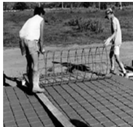
Figura 18: Estampado con malla de acero electrosoldada y estampado con malla de acero electrosoldada con rolo, respectivamente (Fuente: Begliardo et al. , 2015).
