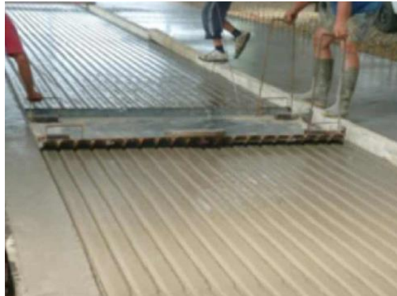
Figura 17: Ranurado en hormigón fresco utilizando molde metálico (Fuente: Begliardo et al. , 2015).
