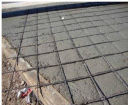
Figura 18: Estampado con malla de acero electrosoldada y estampado con malla de acero electrosoldada con rolo, respectivamente (Fuente: Begliardo et al. , 2015).
