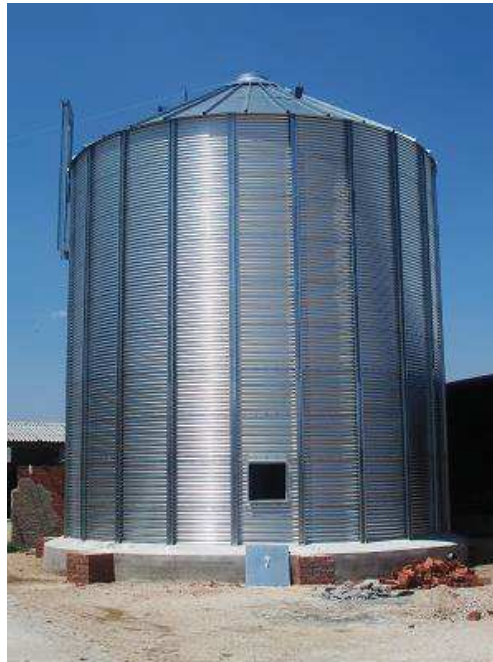
Figura IV – 2. Silo cilíndrico asentado en base de hormigón.
