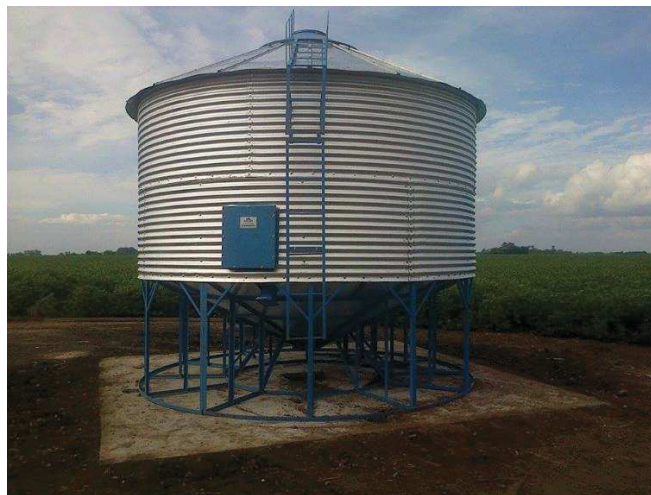
Figura IV – 1. Silo aéreo sustentado por estructura de hierro.
