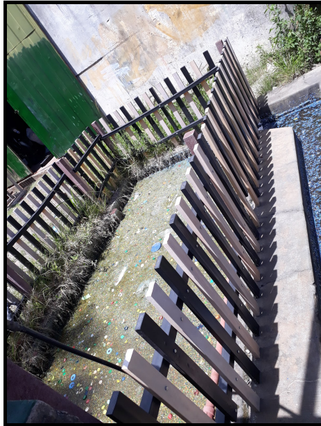
Figura 16. Pileta de tratamiento de agua
