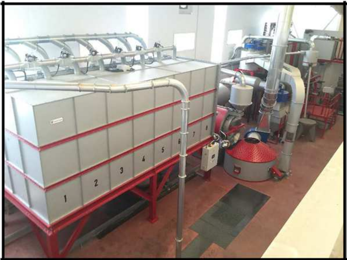
Figure 30: Silos de Almacenamiento Fuente: INNOenvas
