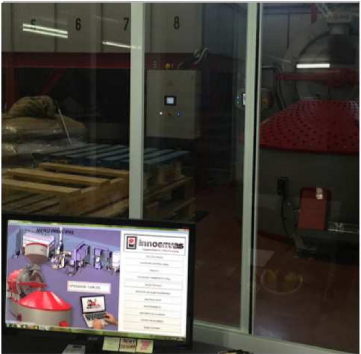
Figure 72: Automatización de la línea Fuente: INNOervas
