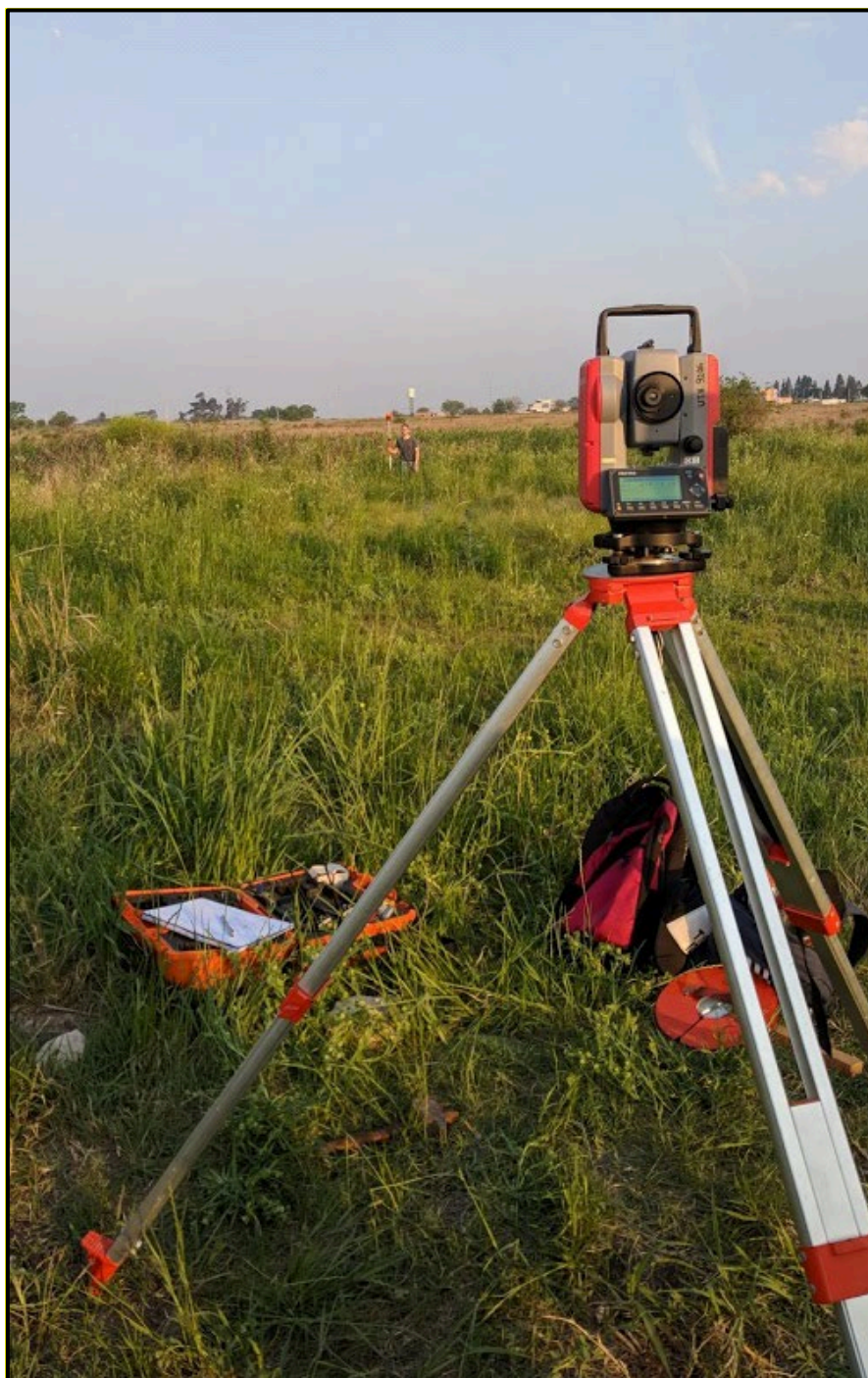
Imagen 4-11 Uso de estación total para relevamiento topográfico
