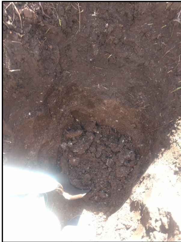
Imagen 7-4 Pozo de extracción P1
