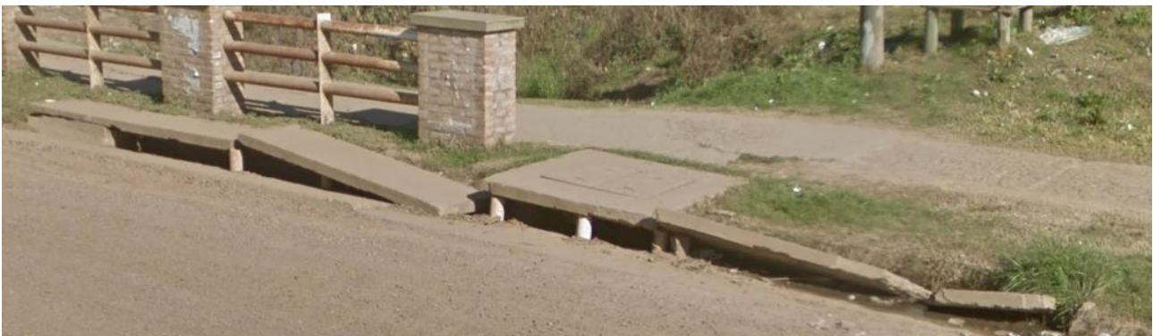
Figura N° 8.8: Sumidero N°11 existente sobre calle presidente Perón.
