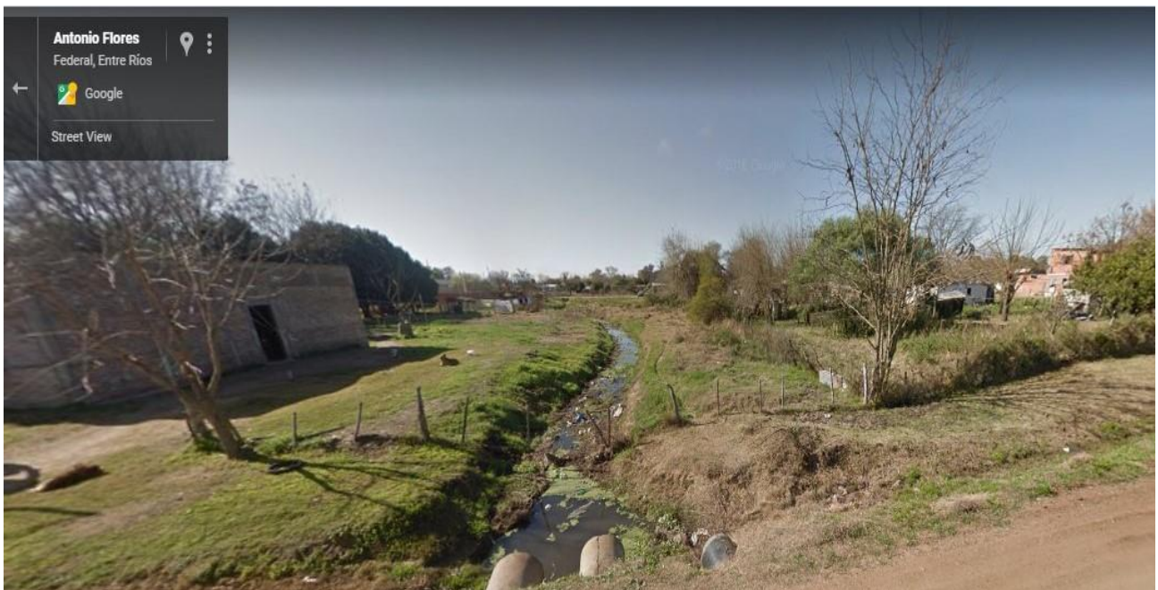
Figura N° 2.17: Imagen de Zona de Riesgo Ambiental. Calle Antonio Flores.
