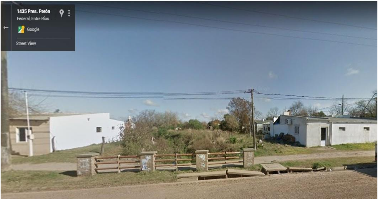
Figura N° 2.20: Imagen de Zona de Riesgo Ambiental. Calle presidente Perón.
