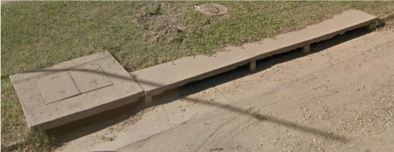
Figura N° 8.9: Sumidero N°12 existente sobre calle presidente Perón.
