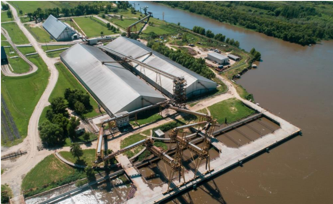
Ilustración 5 - Celdas de almacenamiento
