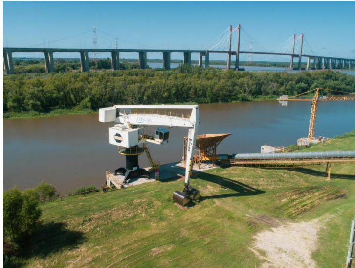
Ilustración 1 - Grúa de recepción por barcazas
