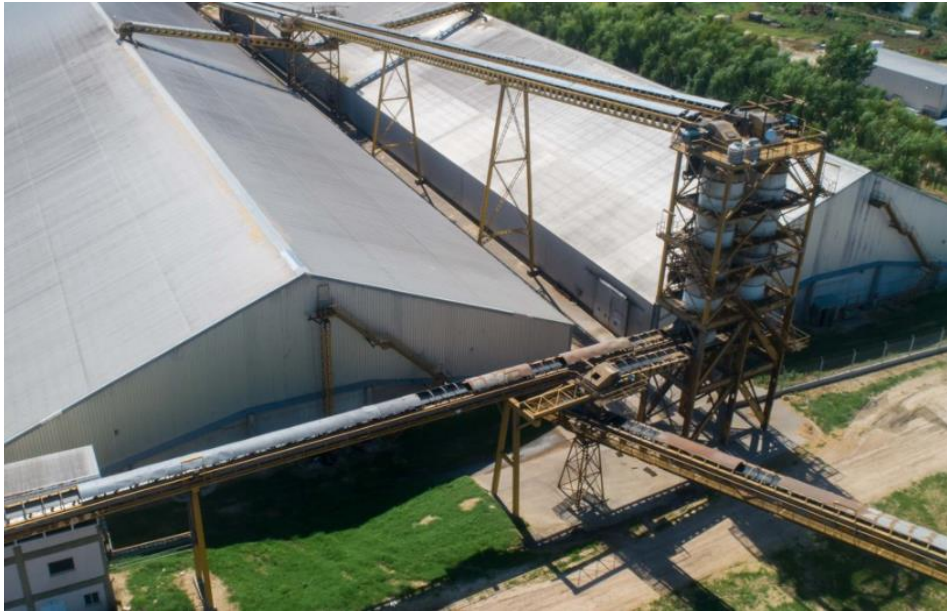
Ilustración 7 - Líneas de embarque, balanza y distribuidor bajo balanza
