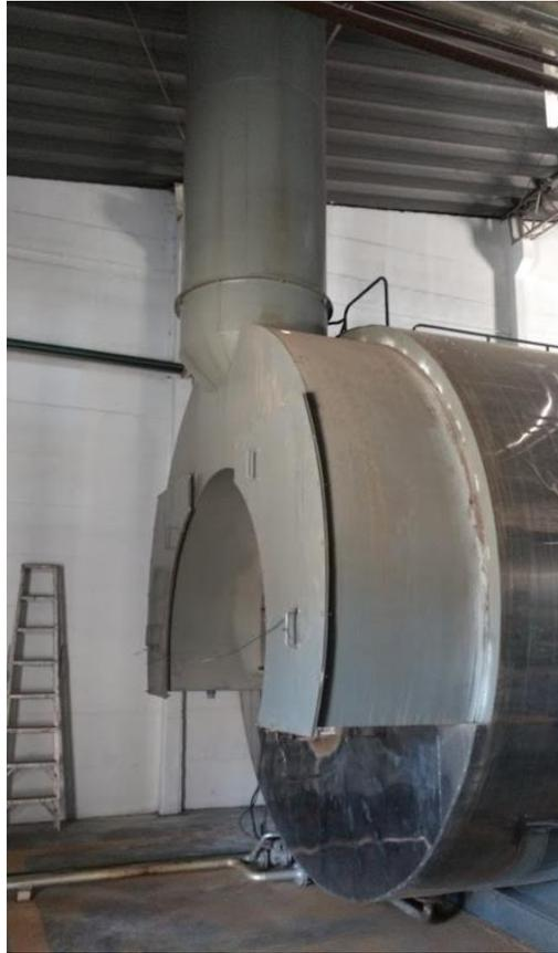
*Fig. 3-2 - Parte frontal con chimenea de la caldera humo tubular del cliente.*
