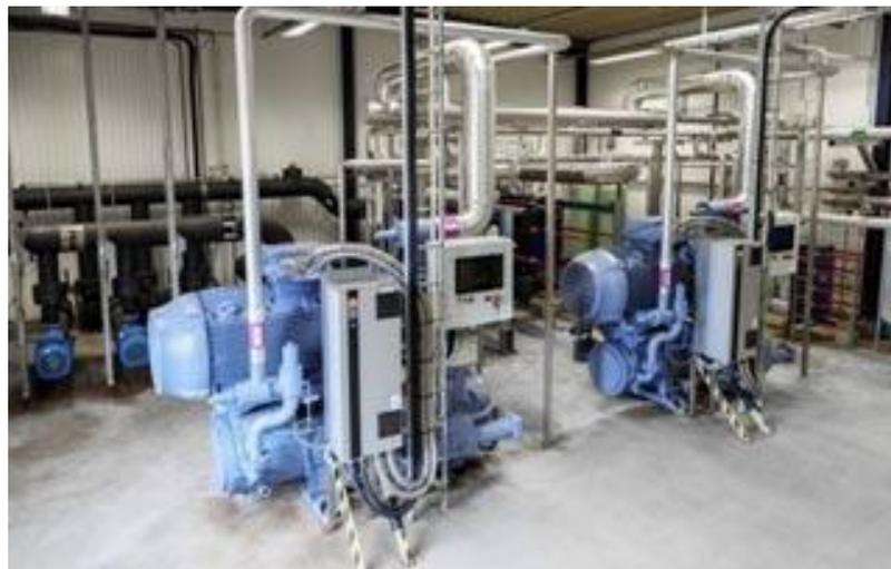
*Fig. 3-3 - Compresor industrial para R22*
