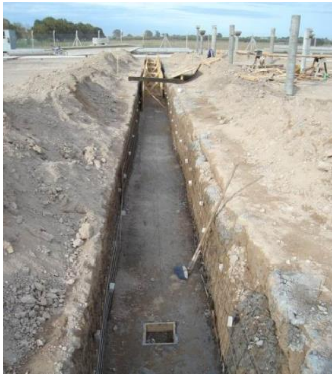
Figura 21: Excavación para canales, previo al hormigonado. Fuente: BRUNO (2011)
