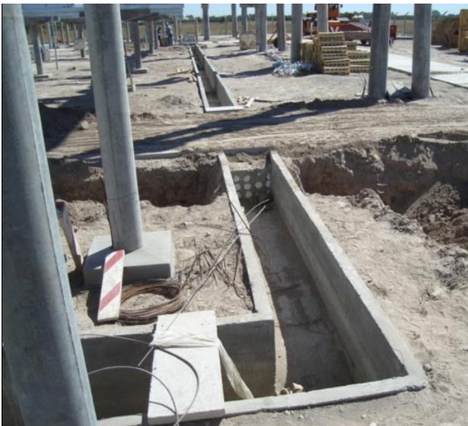
Figura 23: Resolución de cruce de canal y camino Fuente: BRUNO (2011)
