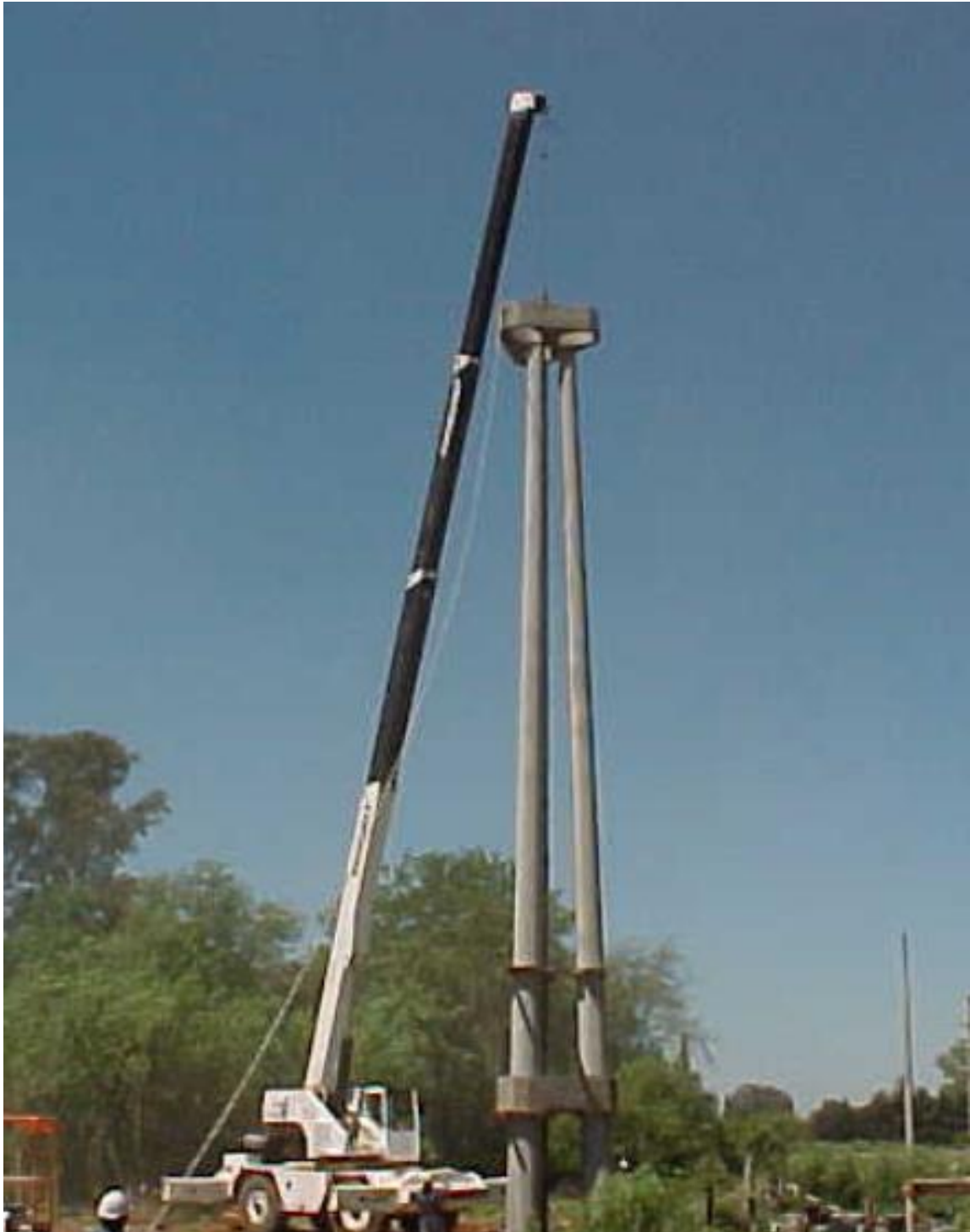
Figura 17: Una grúa montando un vínculo triple Fuente: BRUNO (2011)
