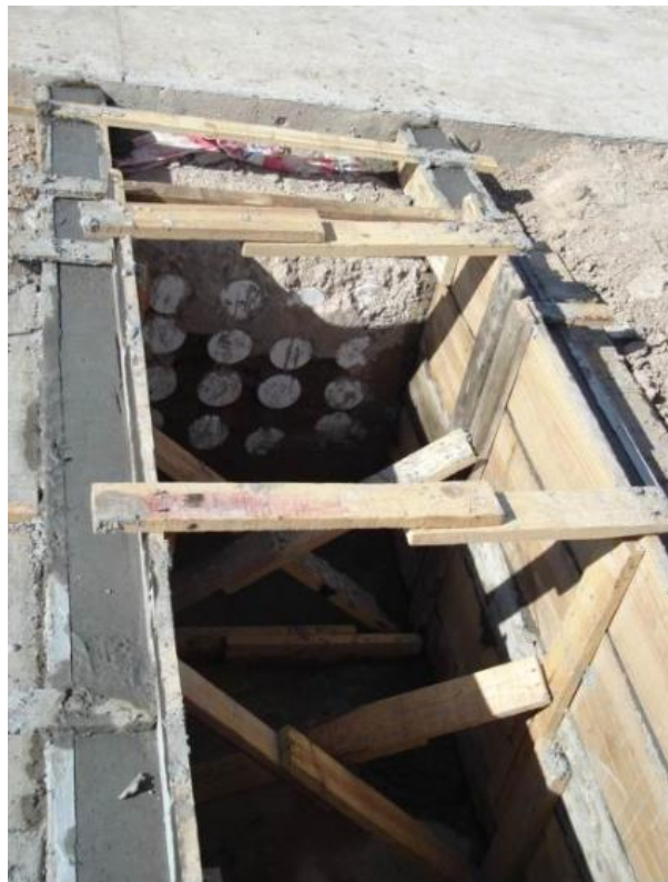
Figura 22: Encofrado para muros de canales Fuente: BRUNO (2011)
