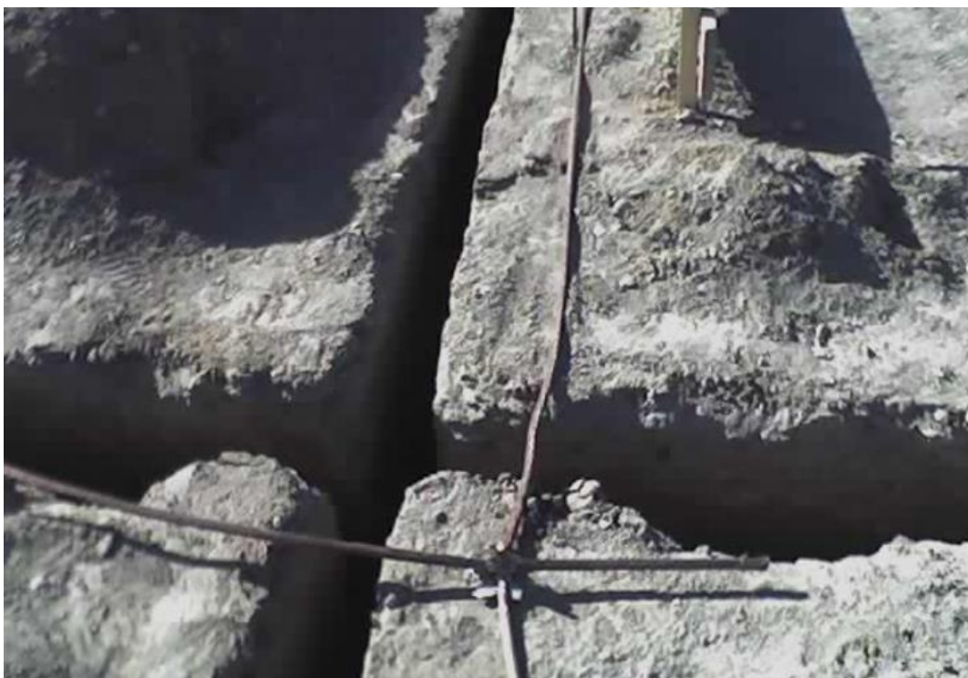
Figura 25: Disposición de los conductores, previo al enterrado
