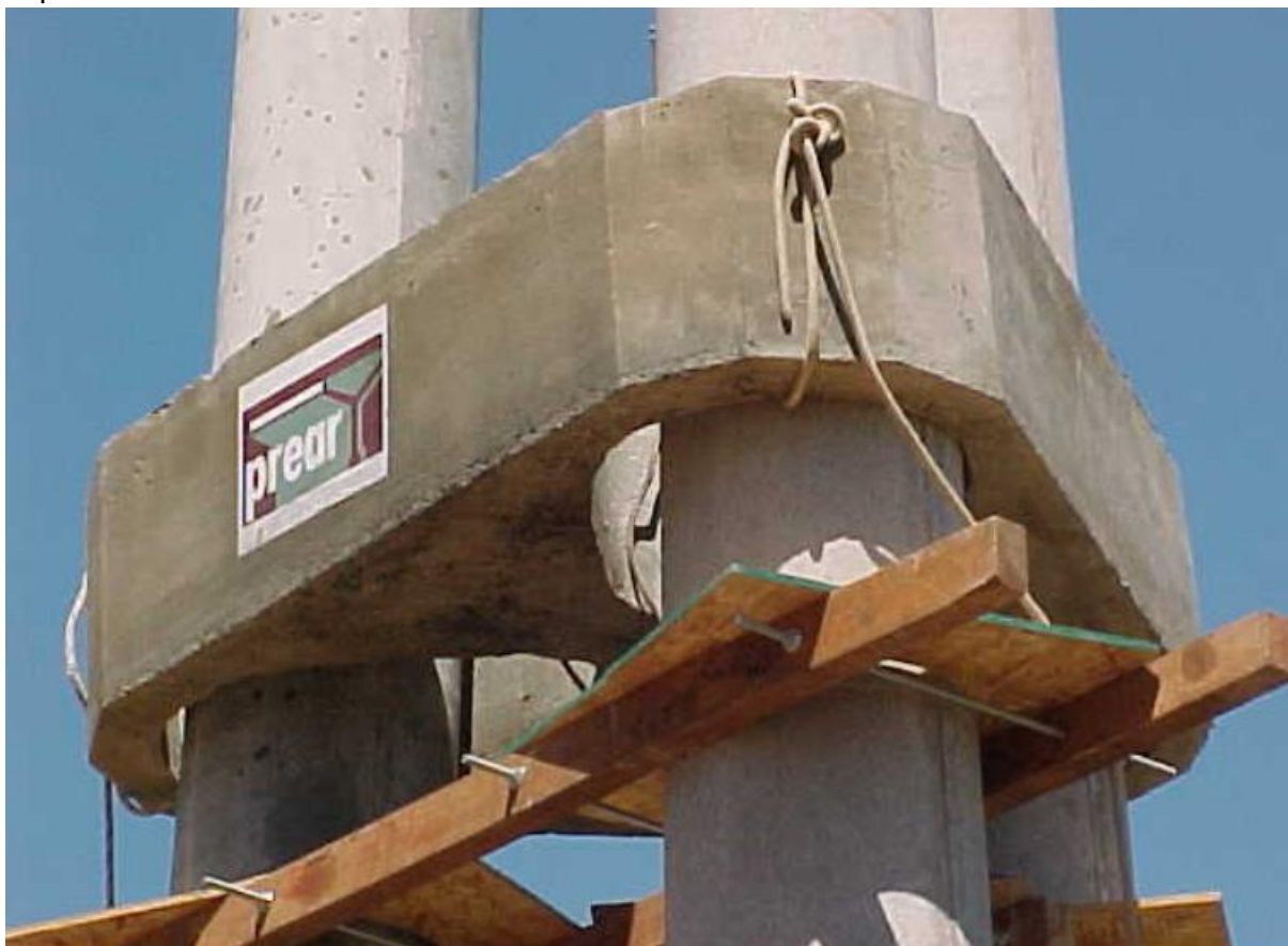
Figura 18: Base provisoria de madera, a modo de encofrado Fuente: BRUNO (2011)
