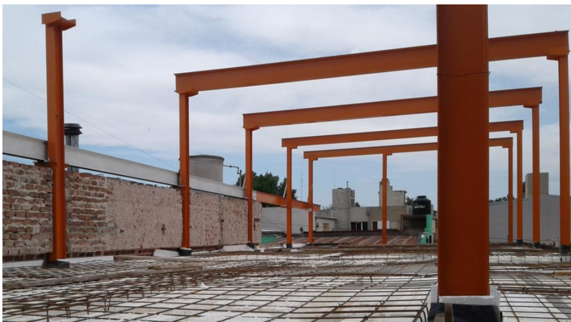
Figura 11. Estructura metálica de la obra en la primera planta.
