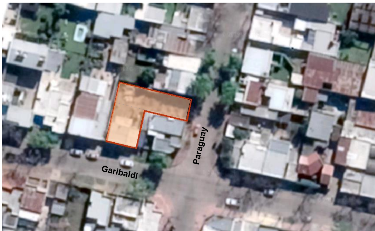
Figura 1. Emplazamiento de la obra
