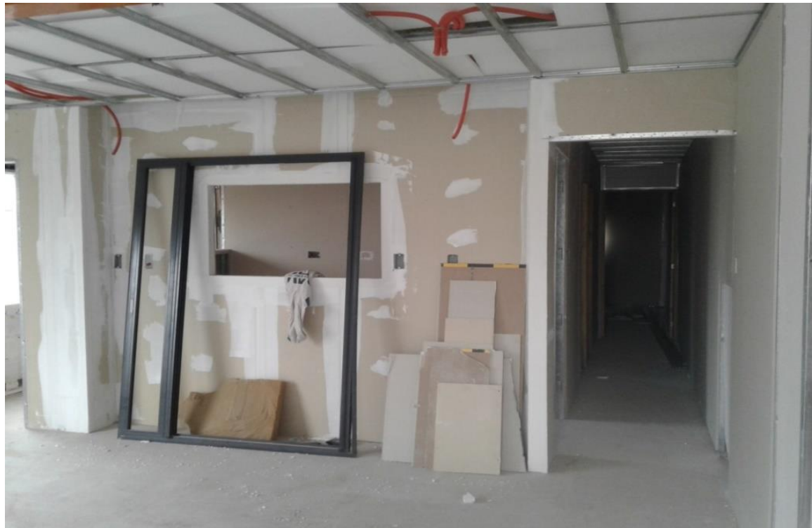
Figura 22. Imagen tomada en la obra analizada durante la ejecución de los cerramientos y revestimientos interiores.
