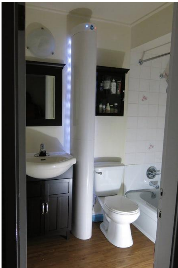
Figura 19. Sistema ReFlow: diseñado y producido en Canadá, reutiliza agua del lavamanos y la ducha dentro de la habitación, usando el tanque (que en la imagen está entre el inodoro y el lavamanos) en la descarga del inodoro. La última información data de 2015, cuando la empresa intentaba empezar a producirlo comercialmente.
