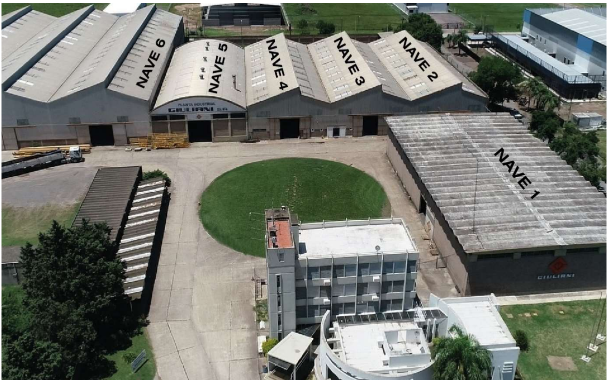
Figura 111: Imagen aérea planta industrial Giuliani Hnos S.A.
