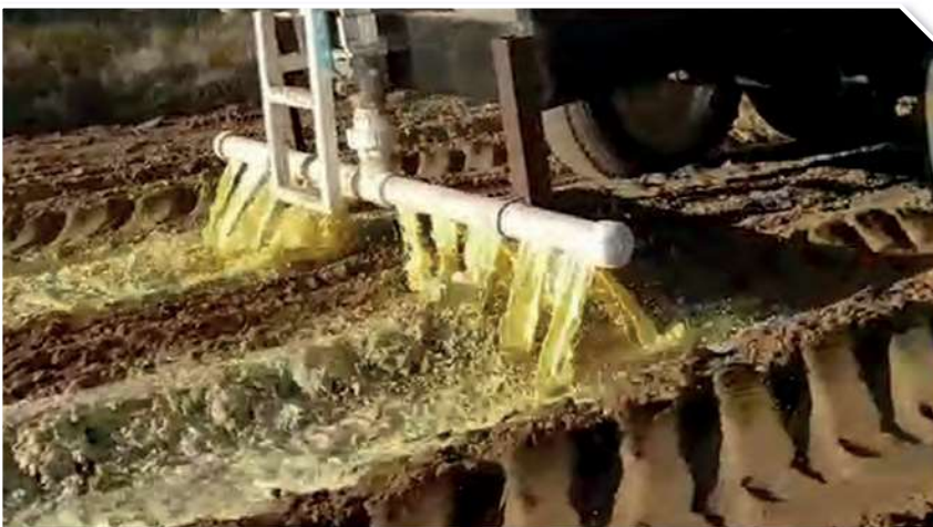
Figura 9: Distribución en obra de la dilución de desgomado de soja
