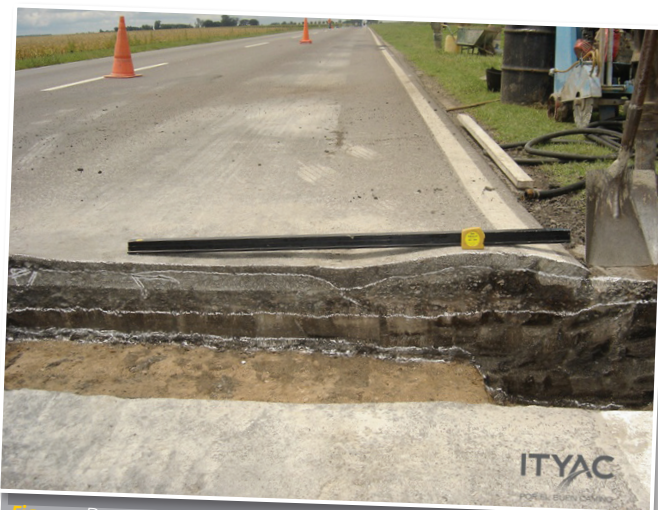
Figura 5 Demarcación e identificación de capas con ahuellamiento.
