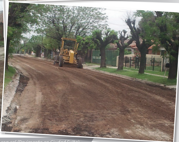
Figuras 3: Base de suelo estabilizado con cal (Pavimento en Ciudad Evita).
