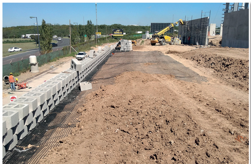
Muro Terrae® - Plaza Logística Ciudad - Etapa constructiva. Relleno y compactación con rodillo pata de cabra sobre geogrilla de refuerzo.
