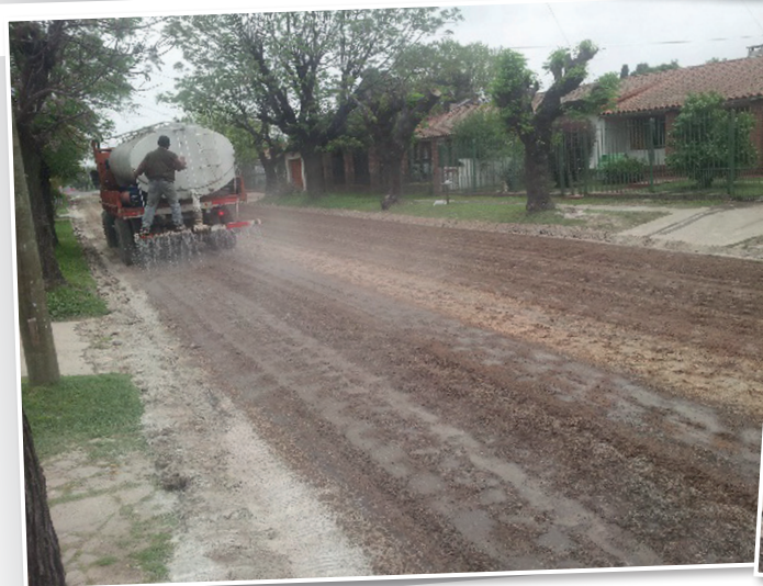
Figuras 3: Base de suelo estabilizado con cal (Pavimento en Ciudad Evita).
