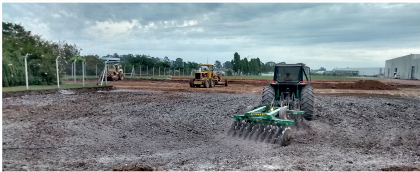
Figura 2: Subrasante de suelo tratado con cal (playa de estacionamiento en un depósito fiscal, área de promoción El Triángulo, Malvinas Argentinas, Buenos Aires).
