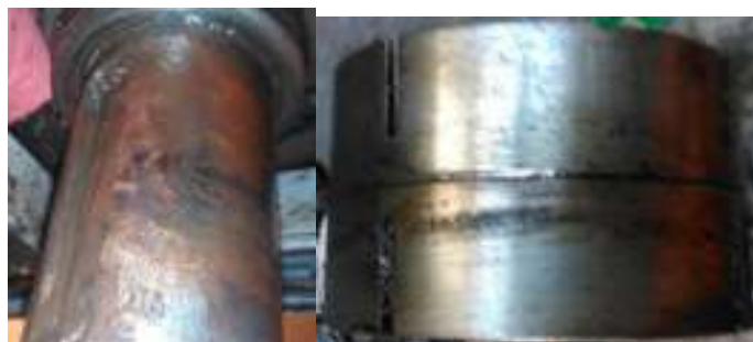
Figura 10: Fotos el eje con corrosión y el manguito con signos de giro en la superficie
