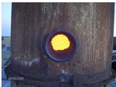
Figura 2: Vista interior de la chimenea de un horno sin tratamiento de gases.
