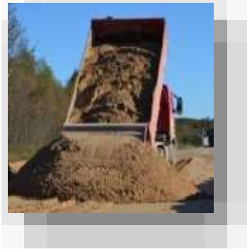
Ilustración. Descarga y acopios de áridos
