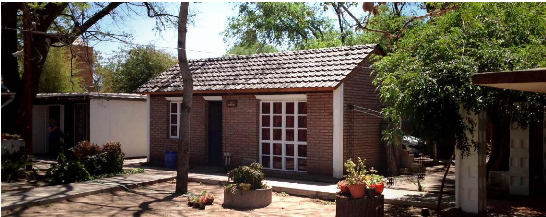
Figura 3. Ventana de hormigón en prototipo BENO – CEVE (1986) Fuente: Web www.ceve.org.ar .
