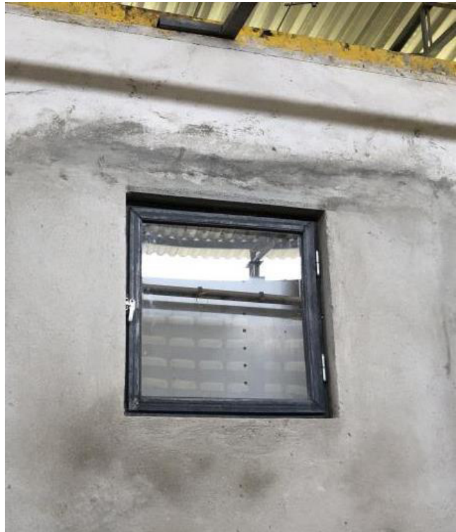
Figura 9. Prototipo instalado previo a ensayos
