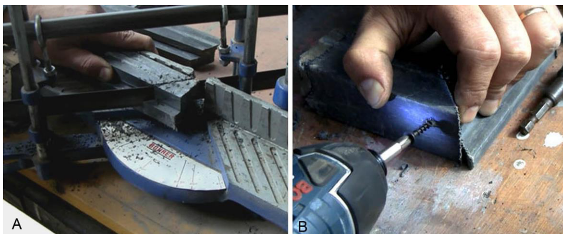
Figura 22. Corte (A) y pruebas de atornillado de perfilería (B). Fuente: (González Laria et al. 2018)
