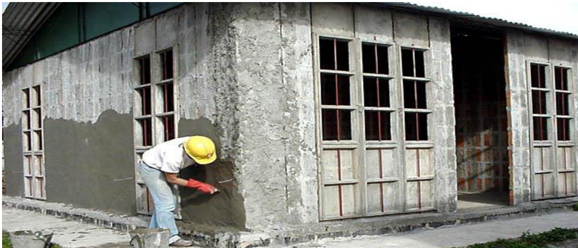
Figura 6. Sistema de placas y ventanas hormigón durante su montaje. Fuente: Web www.ceve.org.ar .
