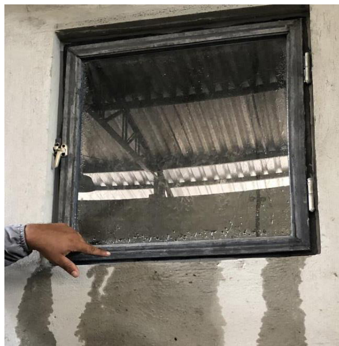
Figura 11. Esgurrimiento inferior sobre el plano interno de la cámara de ensayo
