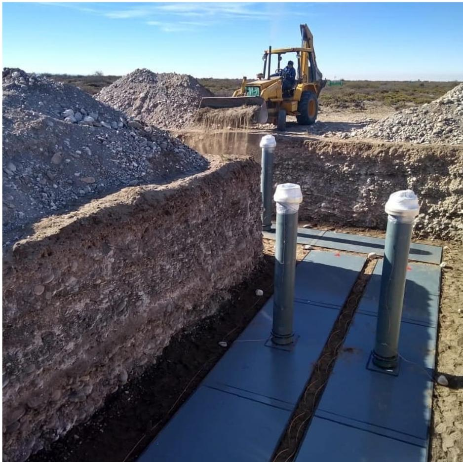
FIGURA 2.10: Instalación de tres módulos contadores de muones ( $10\text{ m}^2$  cada uno, dando un área total de  $30\text{ m}^2$ ) en una posición del *Infill*. En el centro de cada módulo, se ubica el tubo por donde se introduce la electrónica para el contador. Alrededor de cada módulo se observa el cable de la puesta a tierra.
