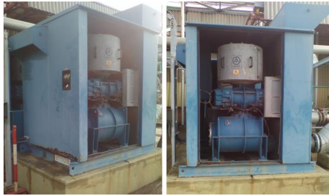
Fig. 1. Un soplante típico montado en su gabinete.
