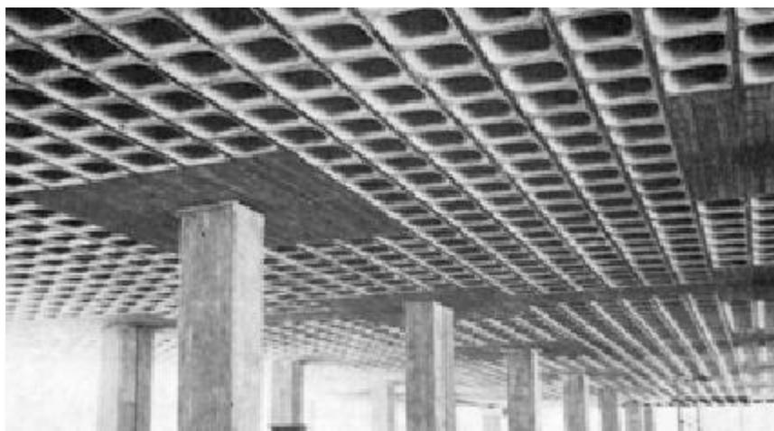
Figura 8-16 - Losa casetonada tipo. Fuente: [www.google.com.ar](http://www.google.com.ar).
