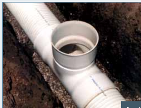
Conexiones SDR 35 en una tubería A-2000
