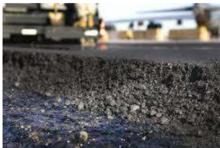
Fig. 2. Mezcla asfáltica en caliente
