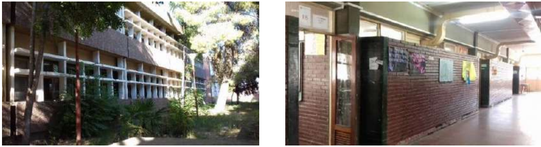
Fig. 1. Imágenes del bloque en estudio (izq. Fachada, der. Pasillo)
