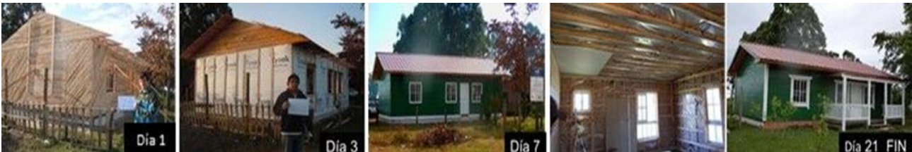
Figura 14: Secuencia construcción de la casa social Emaús- Concordia, en 21 días.
