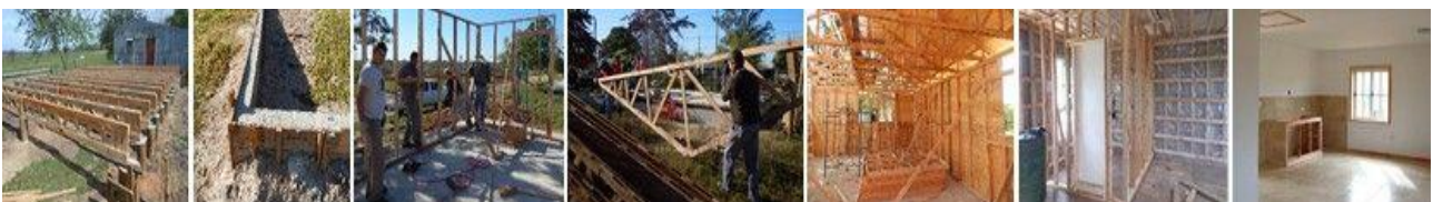
Figura 13: Fundación pilotes –carpeta- muros-cerchas- rigidizado- aislamiento- acabado interior
