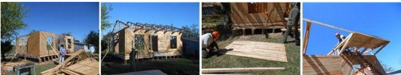
Figura 11: Rigidizaciones con tablas, y paneles de tablas. Casa Ubajay
