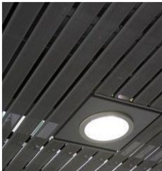
Figura 7-17 | Cielorraso desmontable.
