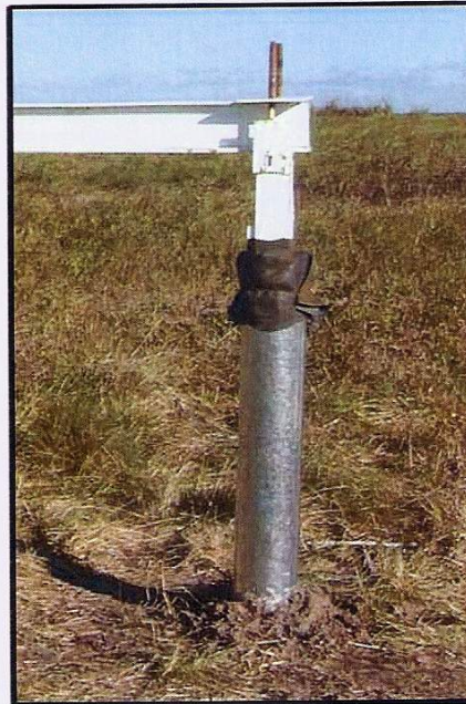
Imagen 14: Camisa y protección del pilar
