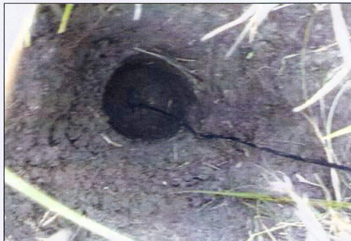
Imagen 19. Sensor de humedad instalado en el pozo
