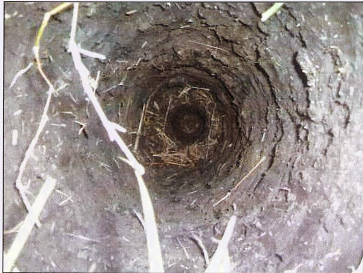
Imagen 15: Pozo realizado con pala vizcachera
