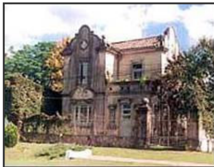
Fig. N° 3-9- Edificio Hospital Liniers (La vieja Calera)
