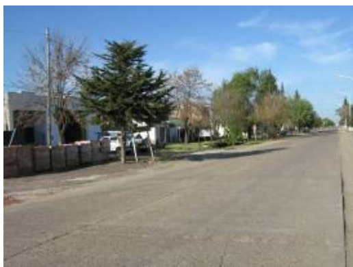
Fig. N° (6-2) - 1 Av. San Martín . Pavimento Rígido Sin banquetas
