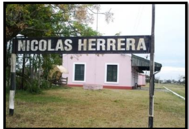
FIGURA II-40 – Edificio Estación Nicolás Herrera
