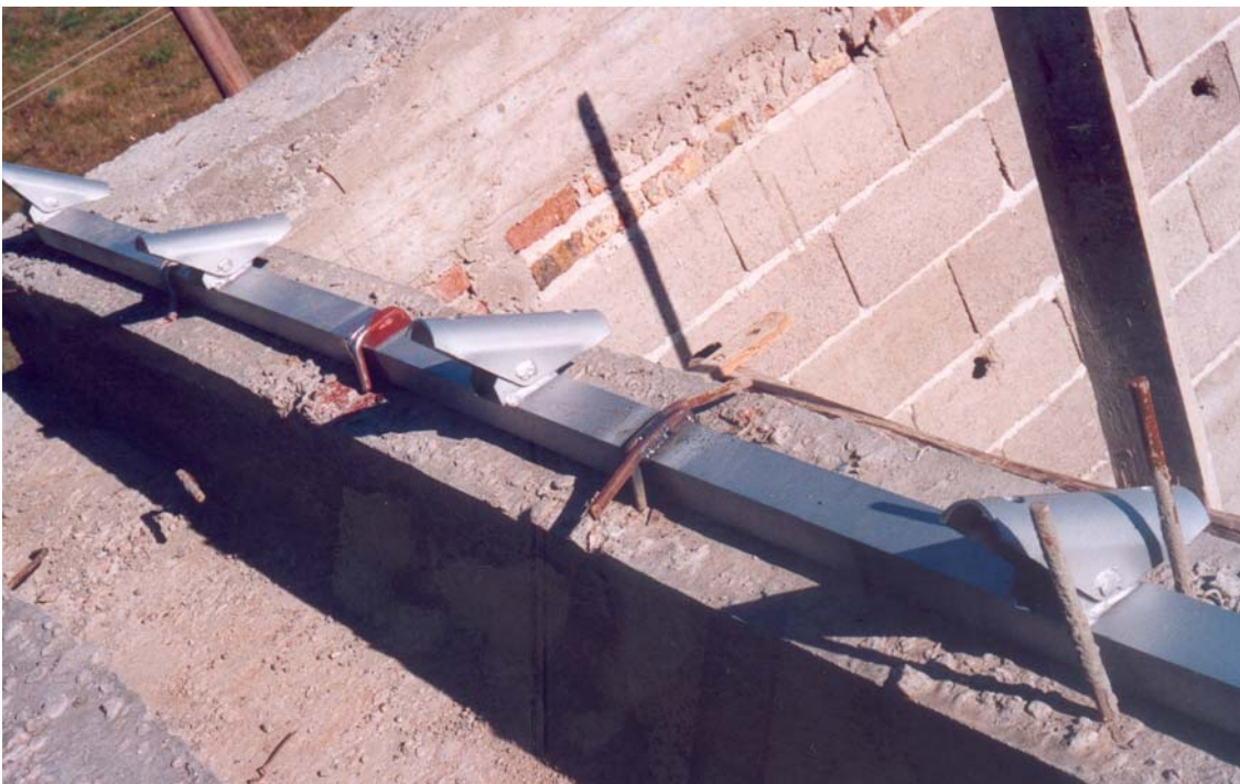
Ilustración 26 – Perfil portacaballetes con los caballetes ya soldados, fijado con bigotes de anclaje
