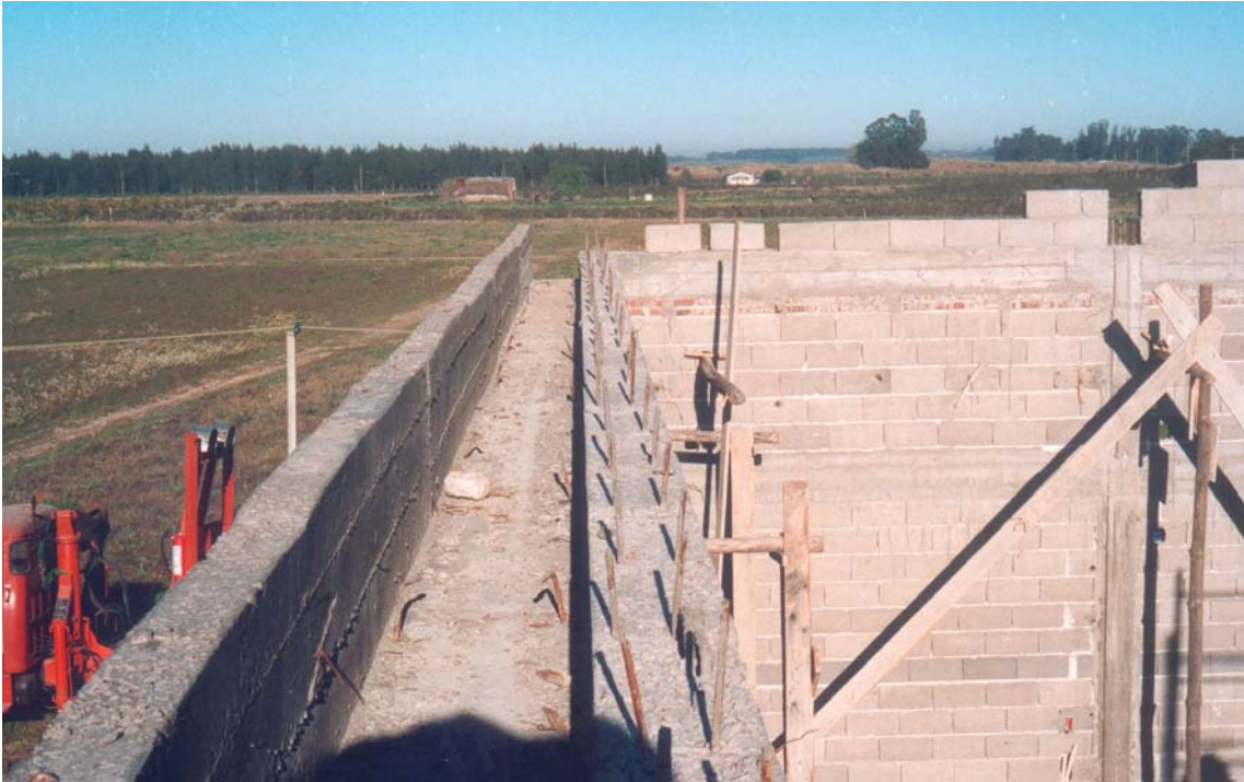
Ilustración 25 – Bigotes de anclaje para fijar el perfil portacaballetes
