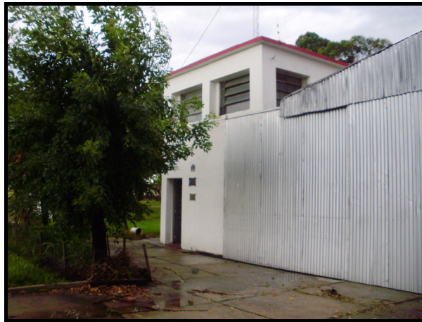
Figura IV-37 - Vista del edificio administrativo
