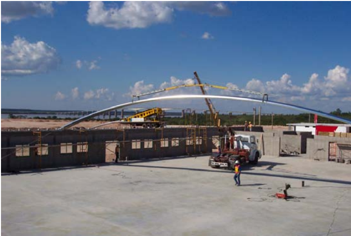
Ilustración 12 – Perfiladora en obra. Para largos mayores a 20m. Comedor Botnia-Fray Bentos
