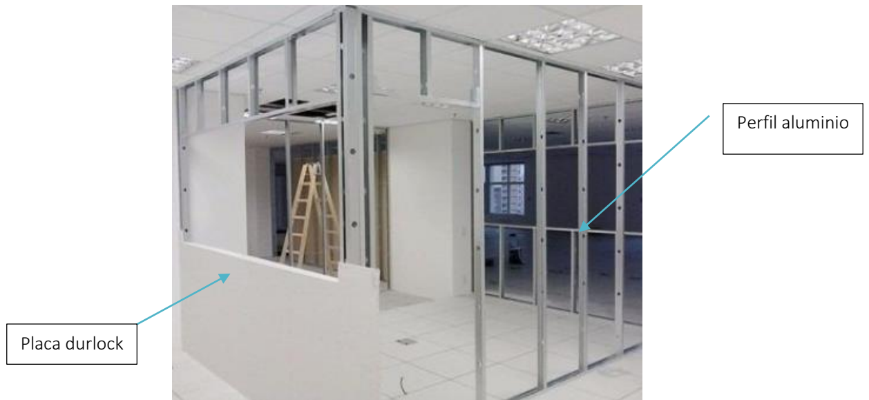
Ilustración 4.44 | Materialidad de boletería
