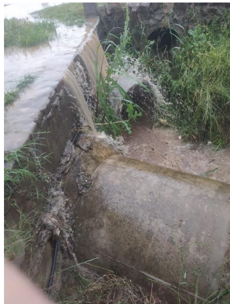
Ilustración 2.17 | Alcantarilla en Paysandú
