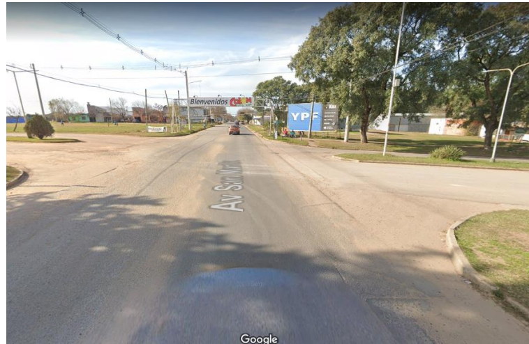
Ilustración 2.33 | Señalización general de la intersección de Cabo Pereyra y San Martín
