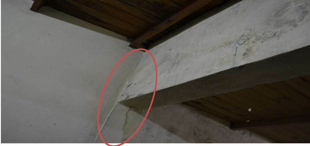
Ilustración 22 - Fisuras debajo de viga.
