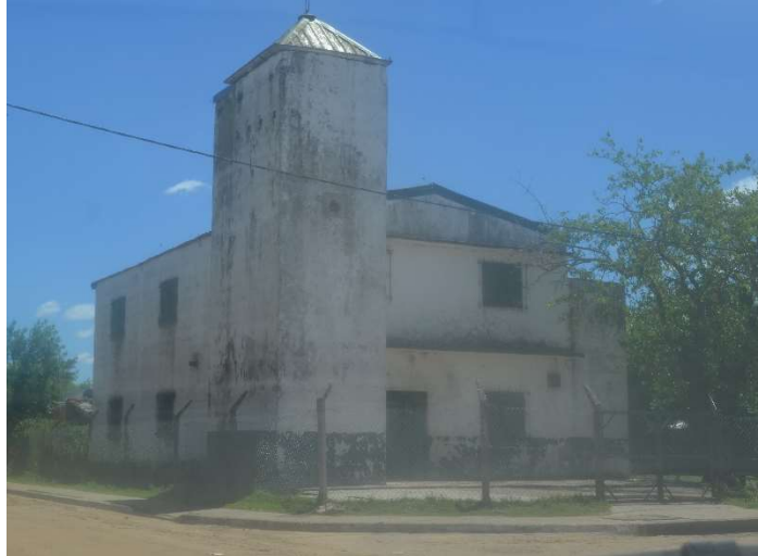
Ilustración 6- Vista desde intersección de calles Perú y Castelli
