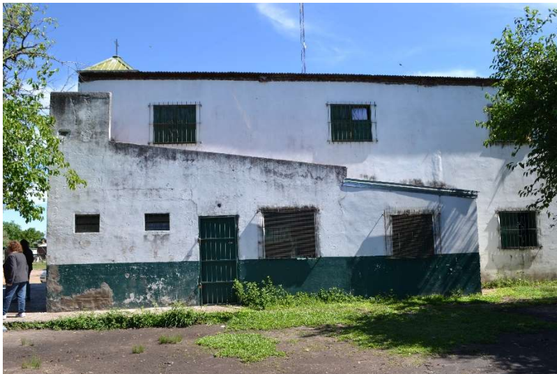
Ilustración 7 - Vista frente Norte
