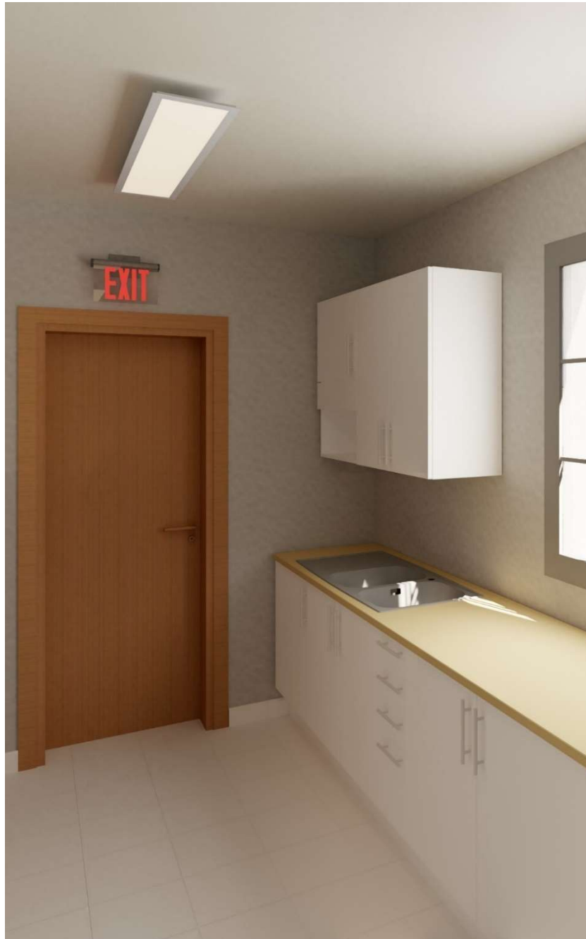
Luminaria tipo led ubicada en la cocina
