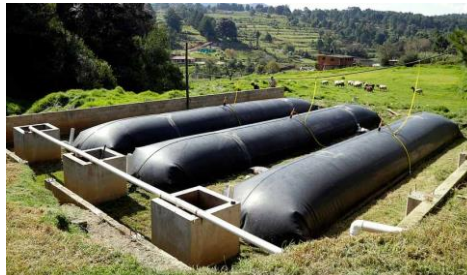
ILUSTRACIÓN 21: BIODIGESTORES TAIWÁN INTERCONECTADOS
