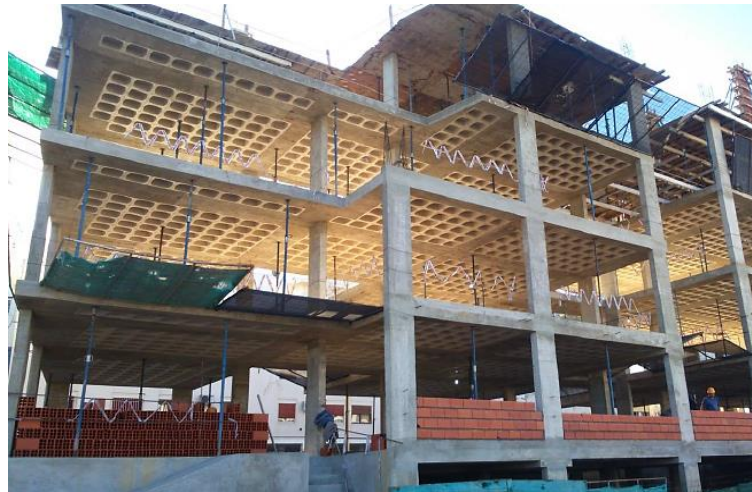
Ilustración 61 - Sistema de entrepisos sin viga con casetonado
