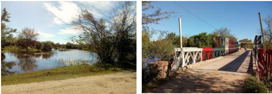
Ilustración 41 – Arroyo La China y Puente existente sobre el mismo.
