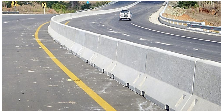
Ilustración 101- Barreras tipo New Jersey
