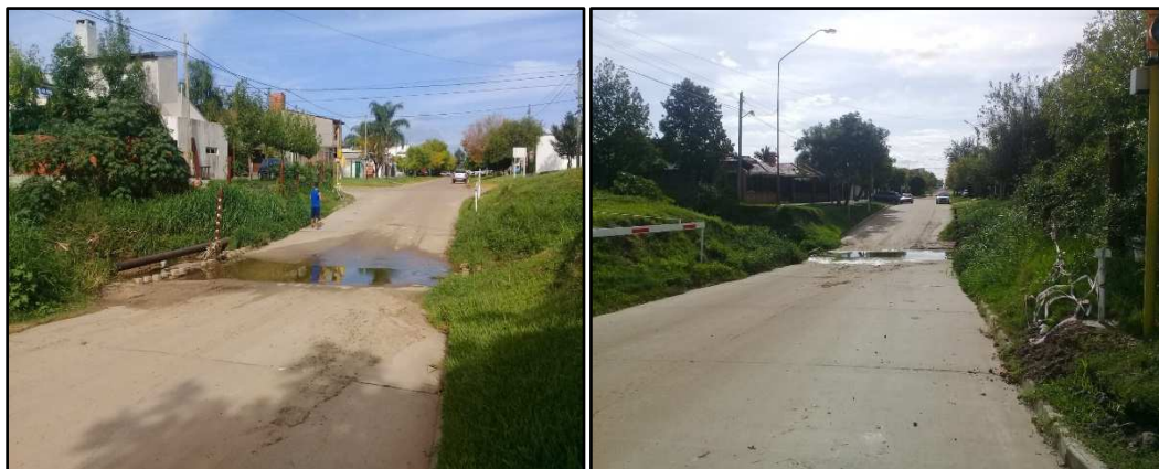
Figura 4.4 - Intersección de arroyo Yacaré y calle Álvarez Condarco. Fuente: Autor.
