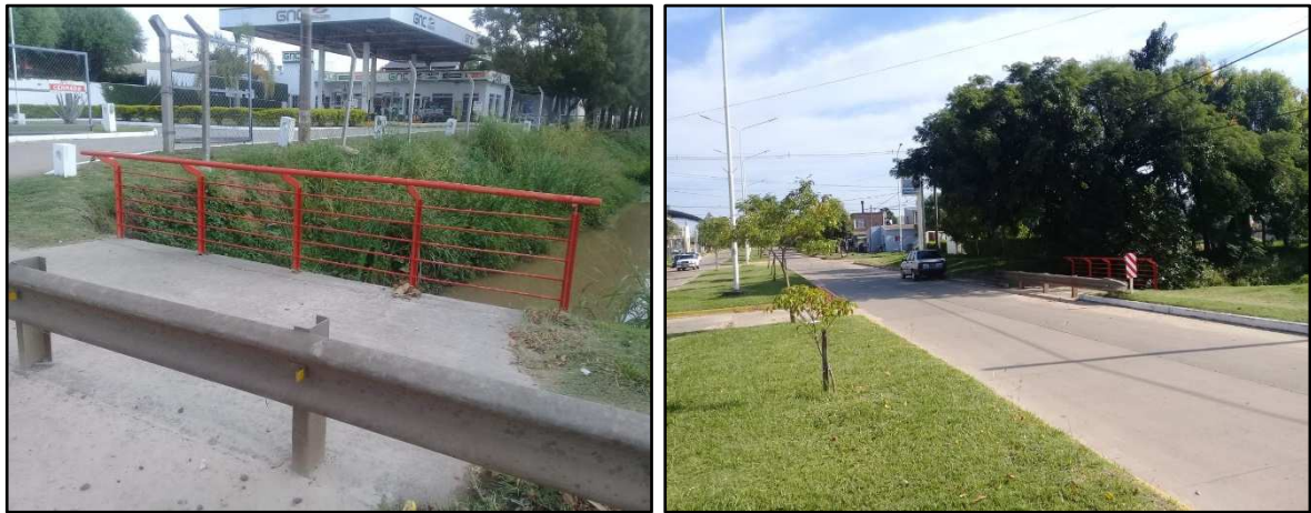
Figura 4.63 – Obra de pavimento sobre alcantarillado. Fuente: Autor.
