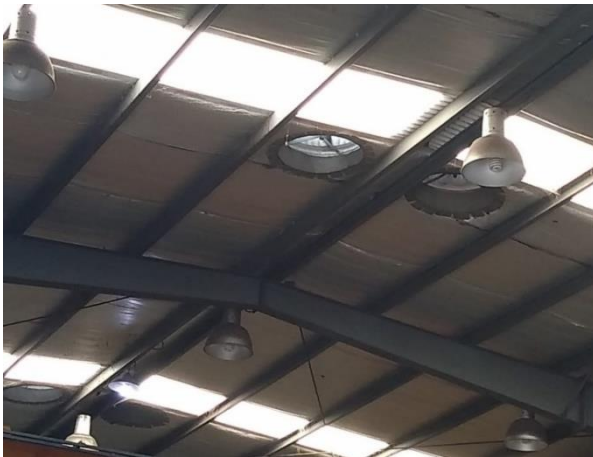
Forzadores naturales eólicos ubicados en Taller de Válvulas
