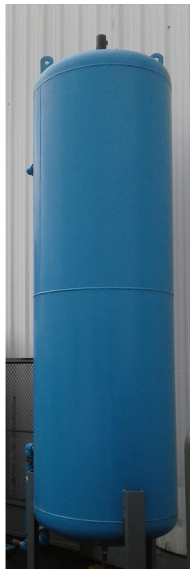
Pulmón de aire comprimido PA4
