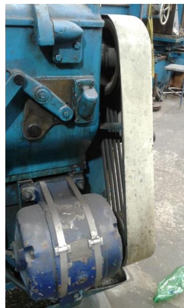
Protección mecánica en Torno
