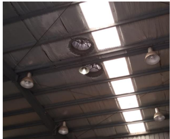
Forzadores naturales eólicos ubicados en Taller de Válvulas
