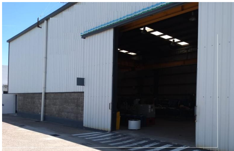
Portón de ingreso al Taller de Válvulas
