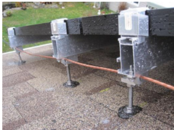
Figura 3.37 Puesta a tierra de los paneles.
