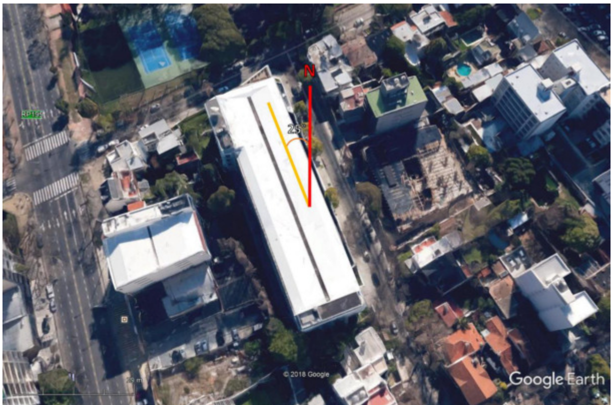
Figura 5.10 Orientación de los paneles.
