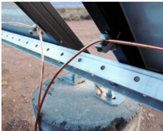
Figura 3.37 Puesta a tierra de los paneles.
