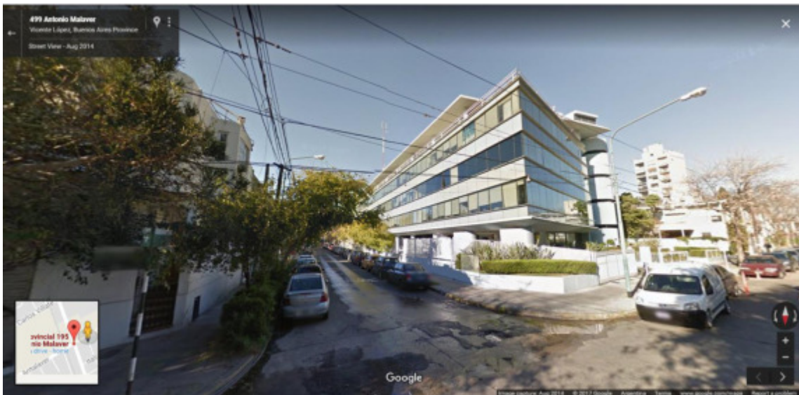
Figura 2.6 Vista de la fachada del edificio
