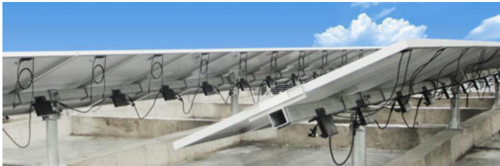
Figura 3.17 Esquema de inversor integrado (arr) y fotografía (aba).
