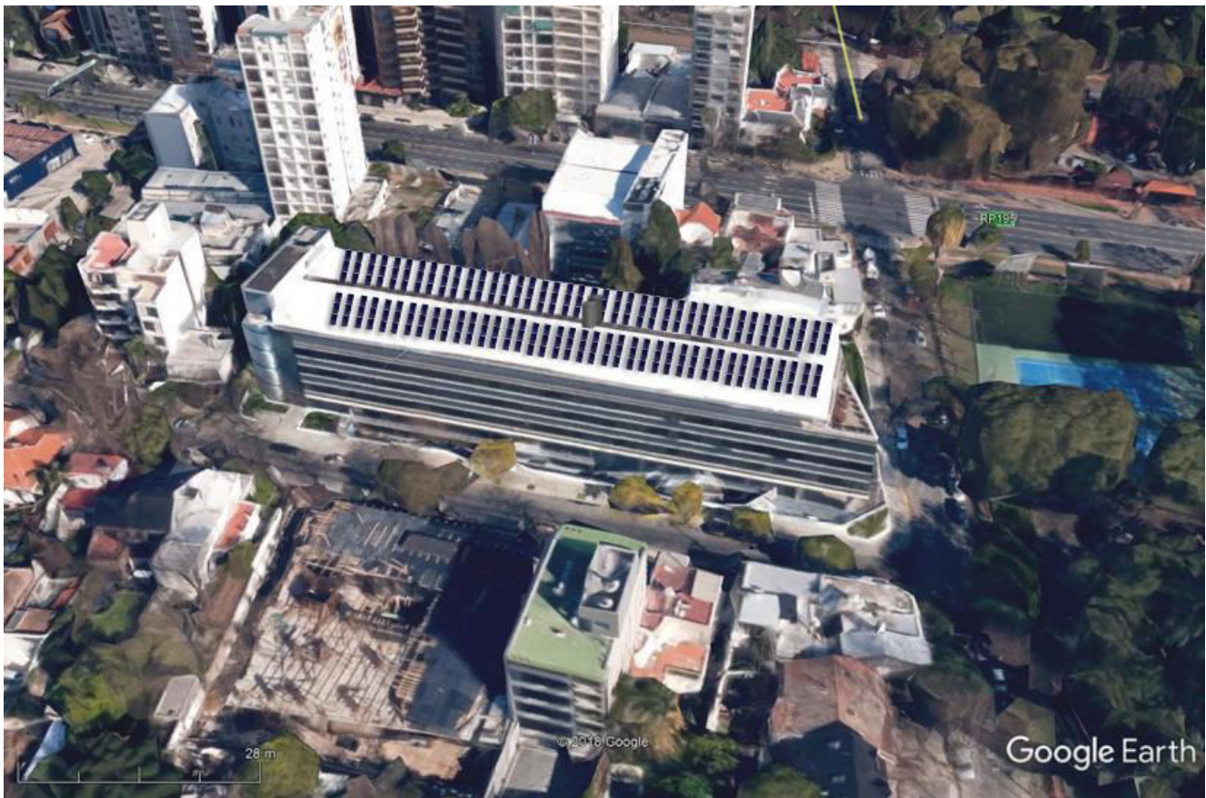
Figura 10.16 Vista aérea edificio con instalación FV
