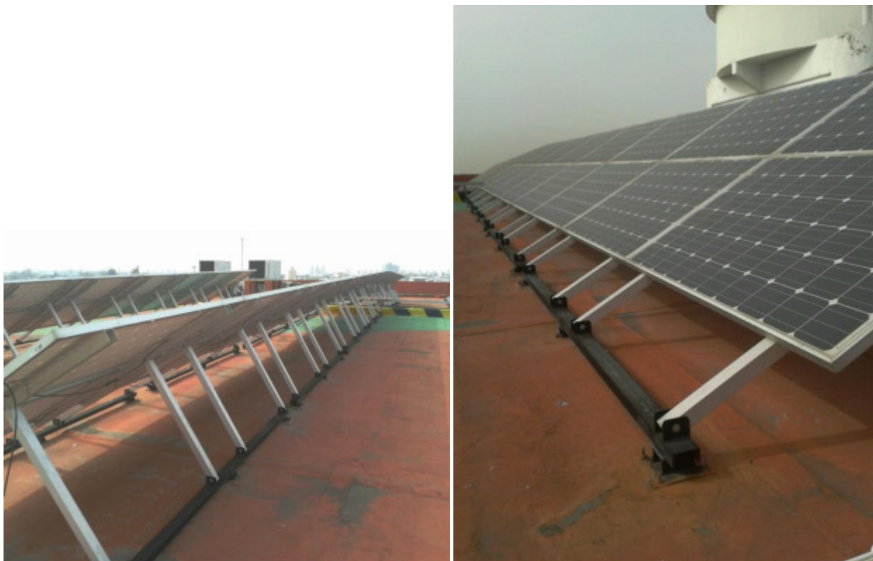
Figura 5.8 Estructura sobre terraza de edificio ABB Argentina.
