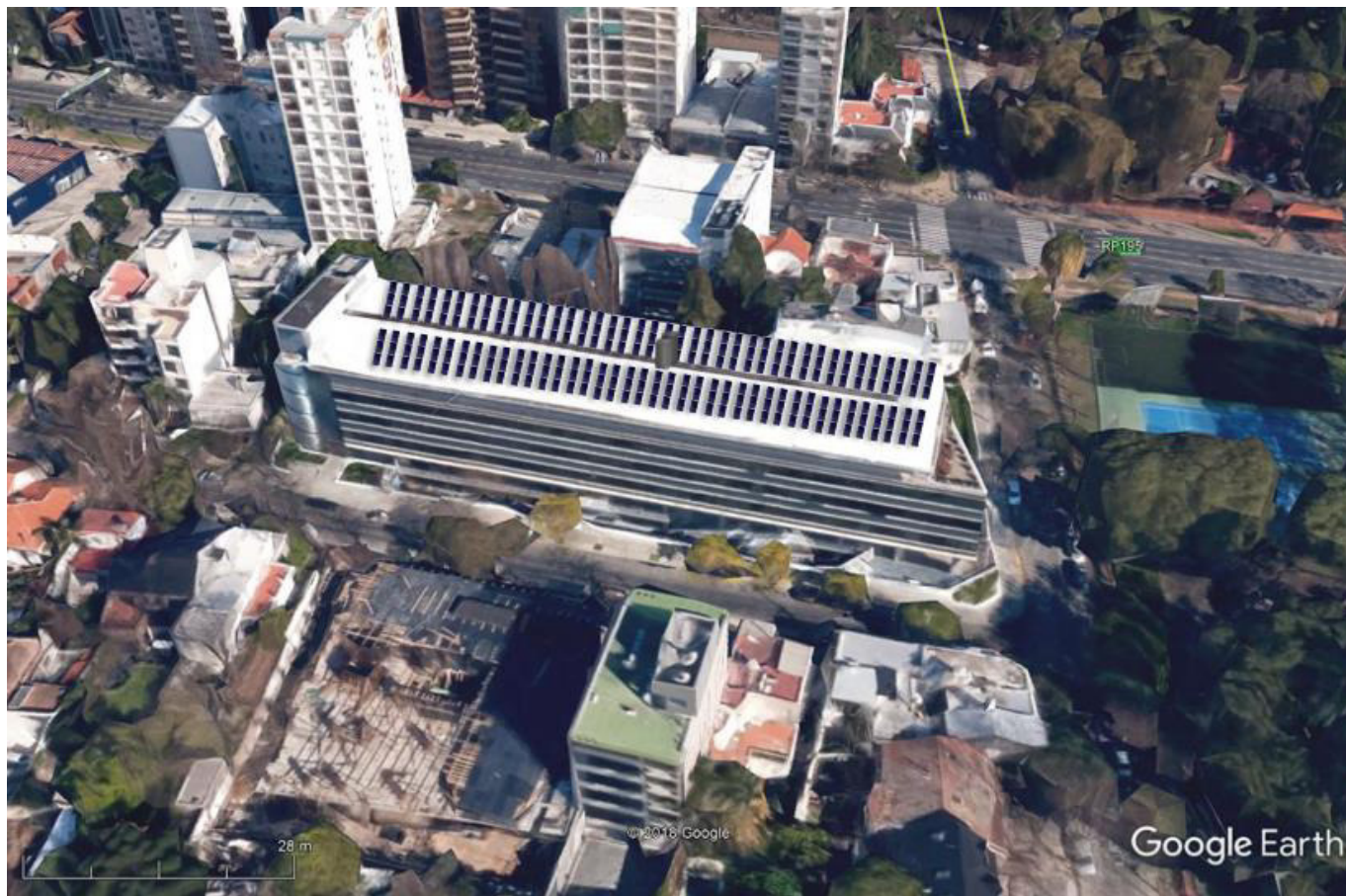
Figura 6.7 Vista aérea edificio con instalación FV
