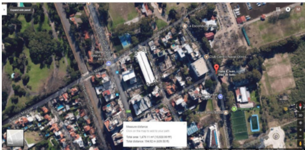
Figura 5.1 Vista aérea del edificio y marcación de la superficie.
