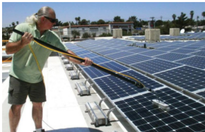
Figura 3.22 Limpieza manual de paneles.
