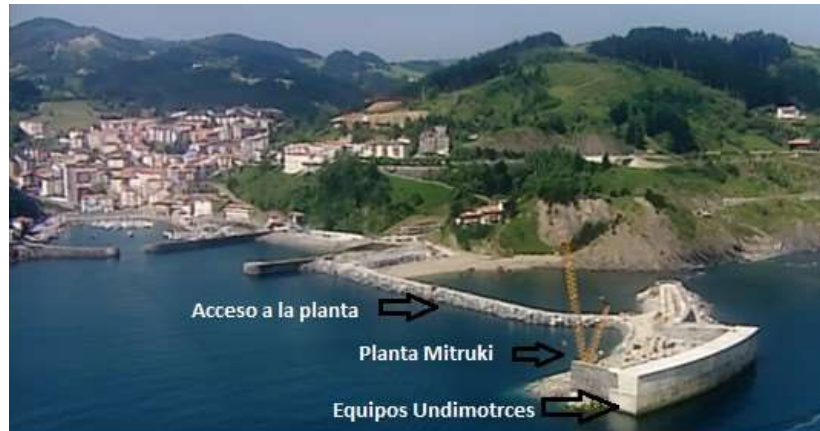
Figura 1-10 Mitruki, España. Sistema undimotriz por columna de agua oscilante.
