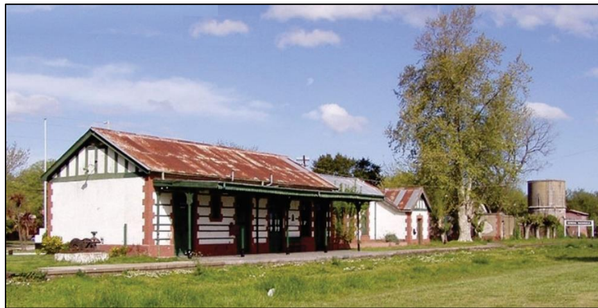
Figura 22: Estación de tren de General Madariaga. Foto tomada de internet.
