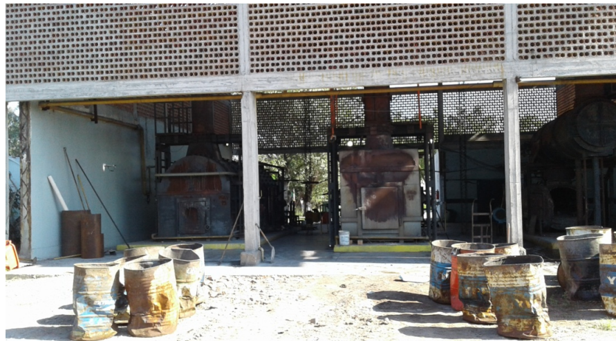
Fotografía 5.2-Vista de frente de Hornos pirolíticos en predio Los Vázquez- Emp. 9 de Julio
