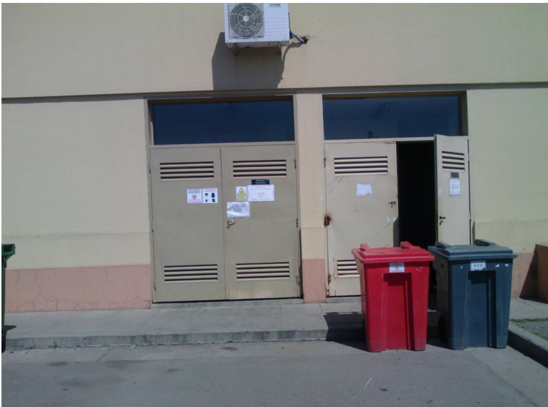
Fotografía 2.13: Sectores de almacenamiento de RP y RSU- Acceso exterior para el operador
