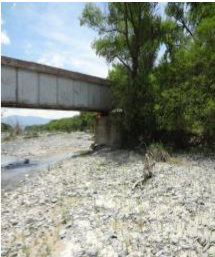
Foto N° 10: Vista del puente ferroviario en la zona noroeste, del Río Choromoro. Trancas. Tucumán. Fuente: Producción propia del autor.
