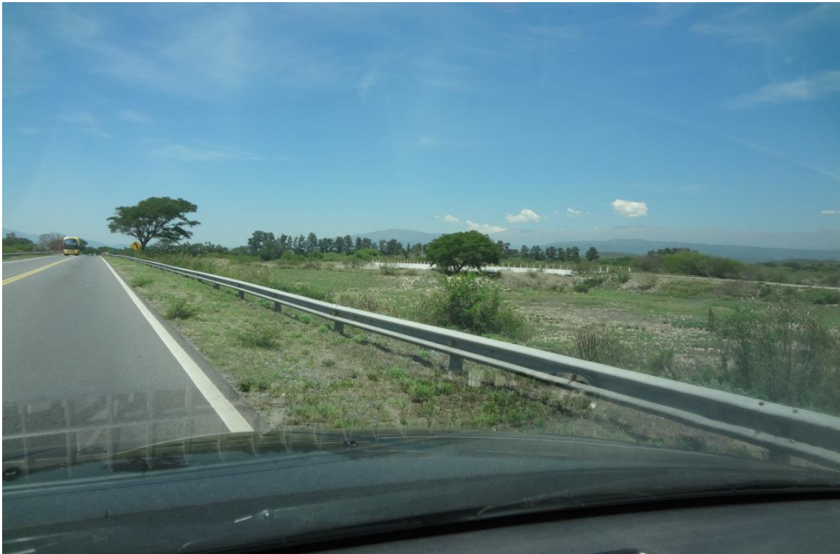
Foto N° 4: Vista de la Ruta Nacional N° 9 junto al Río Choromoro. Trancas. Tucumán. Fuente: Producción propia del autor.
