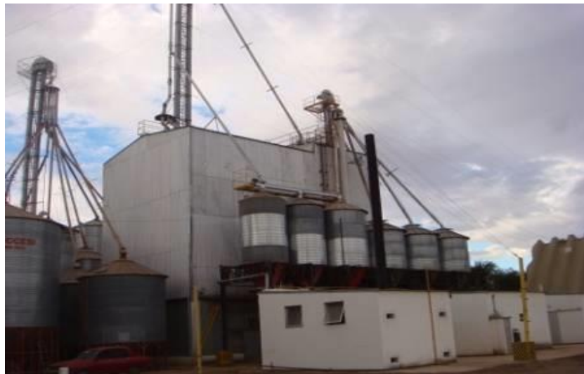
Fig. 1-26. Silos de productos a granel
