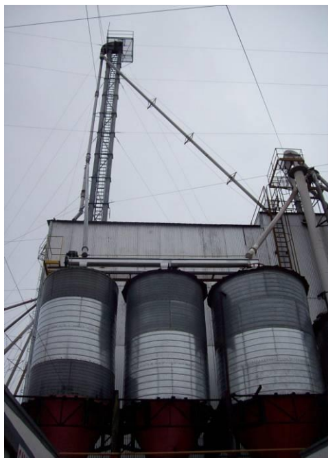
Fig. 1-22. Silos de producto a granel
