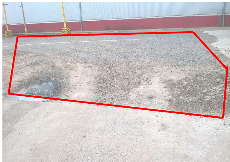
Fig.3-36. Falta materialidad del pavimento, material granular suelto
