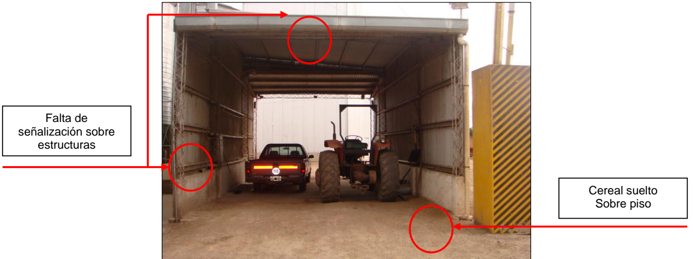
Fig. 2-5. Descarga por gravedad sobre rejilla colectora.
