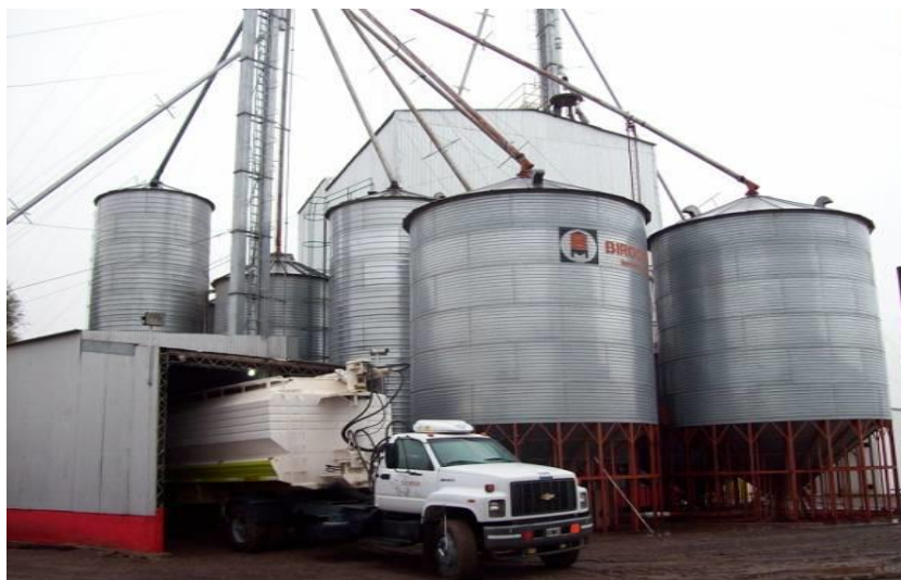
Fig. 1-15. Camión en descarga y silos aéreos
