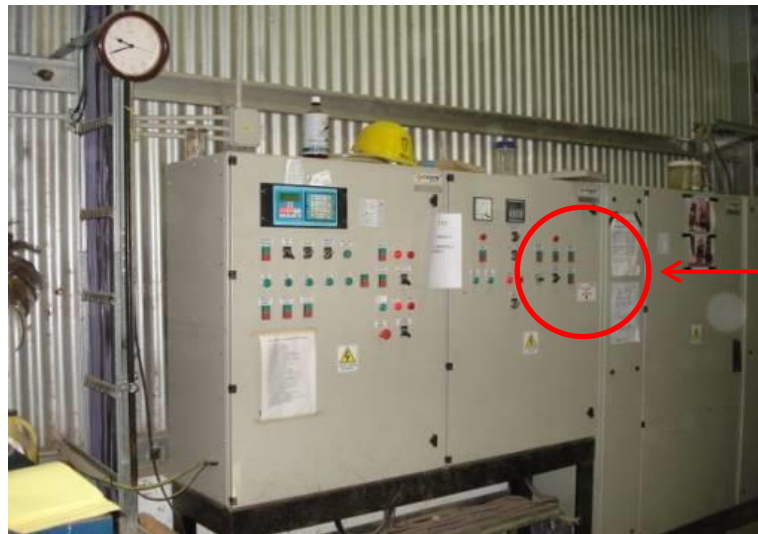
Fig. 3-48. Tableros controladores del proceso de molienda y mezclado (P.L.C)
