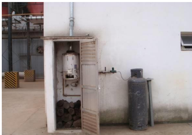
Fig. 1-44. Termo tanque
