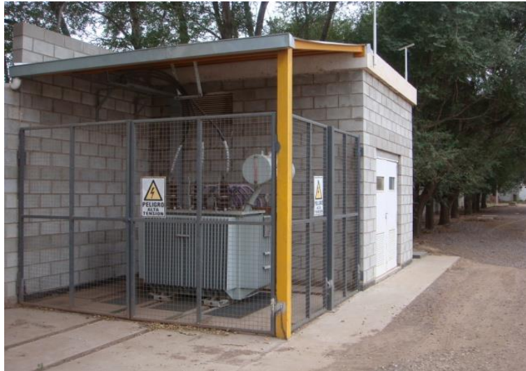
Fig. 1-35. Subestación transformadora
