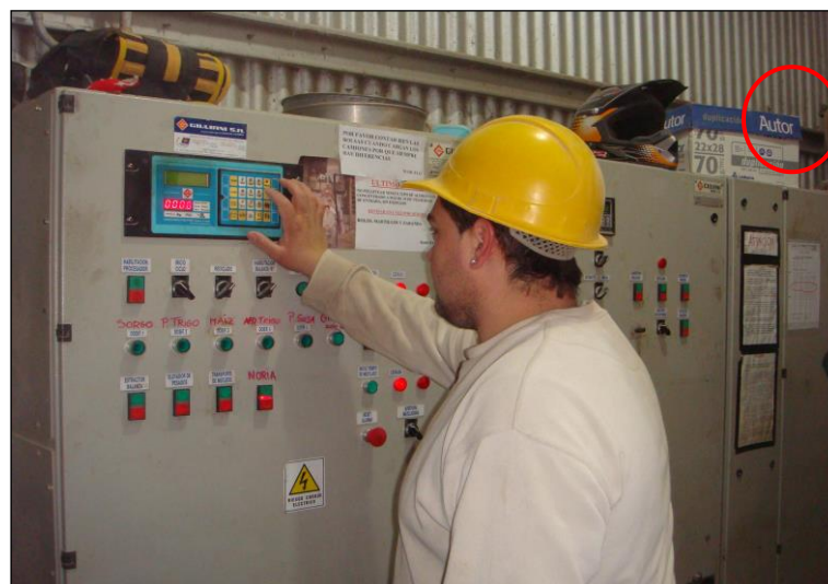
Fig. 2-11. Tablero controlador del proceso mediante PLC.
