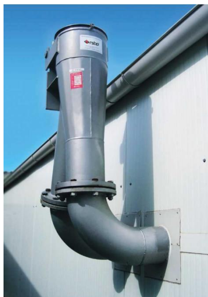
Fig. 3-14. Diversora Anti Explosión
