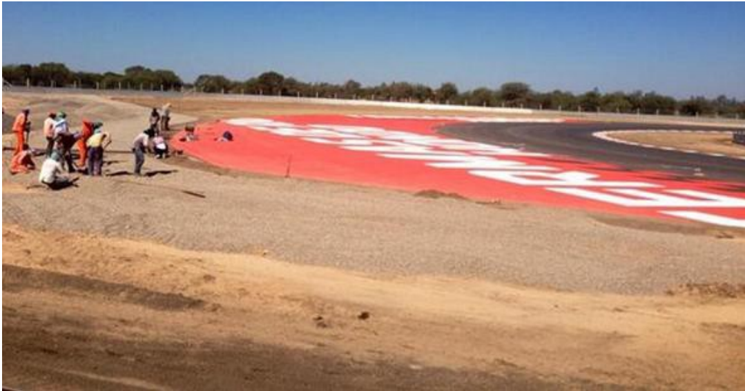
Fig. 10-11 Foto de curva. Se está aplicando la marca en la zona de escape y se coloca leca. [M-11]
