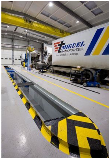
Fig. 1-12 Fosa de inspección de camiones. [D-12]
