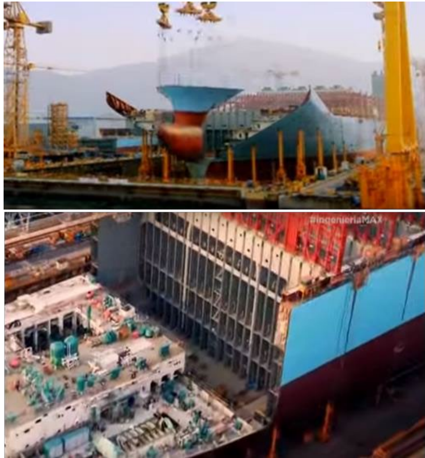
Fig. 3-1 Segmentos del futuro barco en ensamble [D-1]
