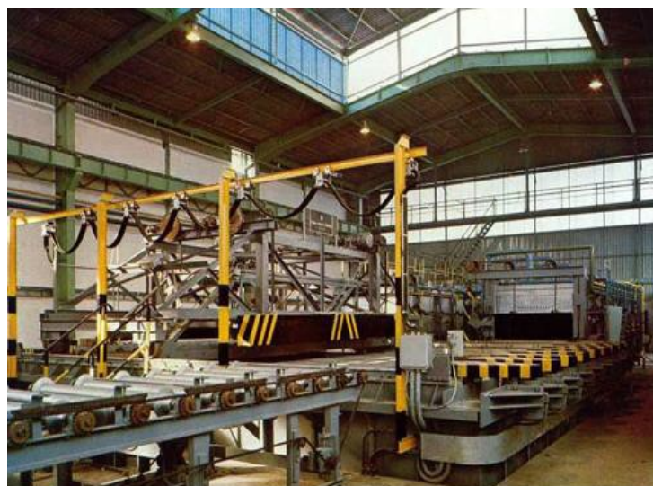
Fig. 3-20 Horno tratamiento térmico carga a rodillos. [D-20]
