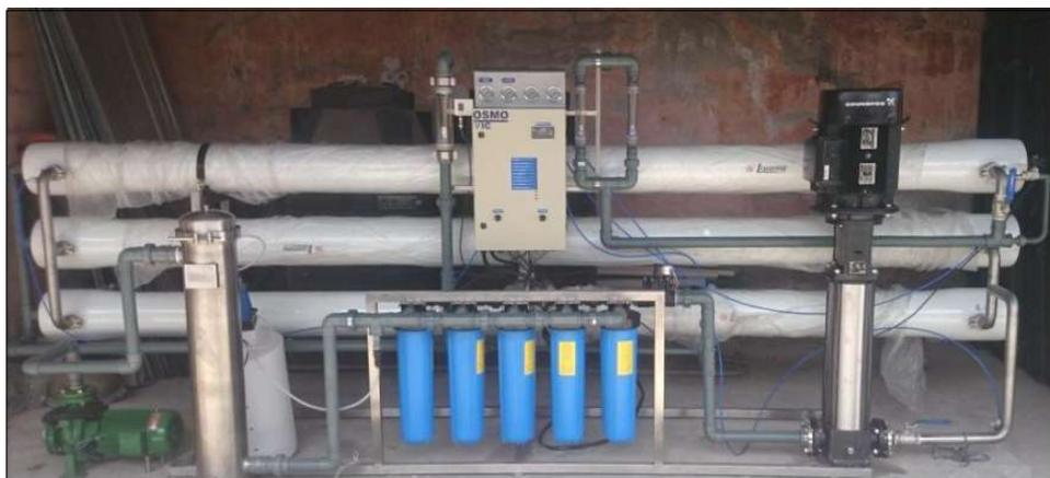
Figura 97. Equipo de Osmosis inversa. Fuente: [www.osmovic.com.ar](http://www.osmovic.com.ar)
