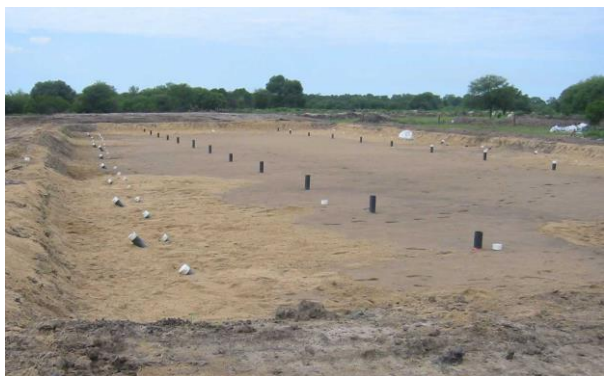
Figura N° 1: Instalación de uno de los pantanos
