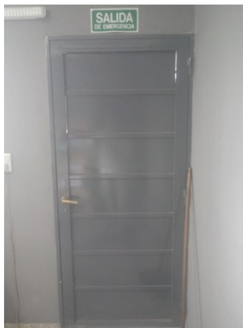
Salida de emergencia de oficinas
