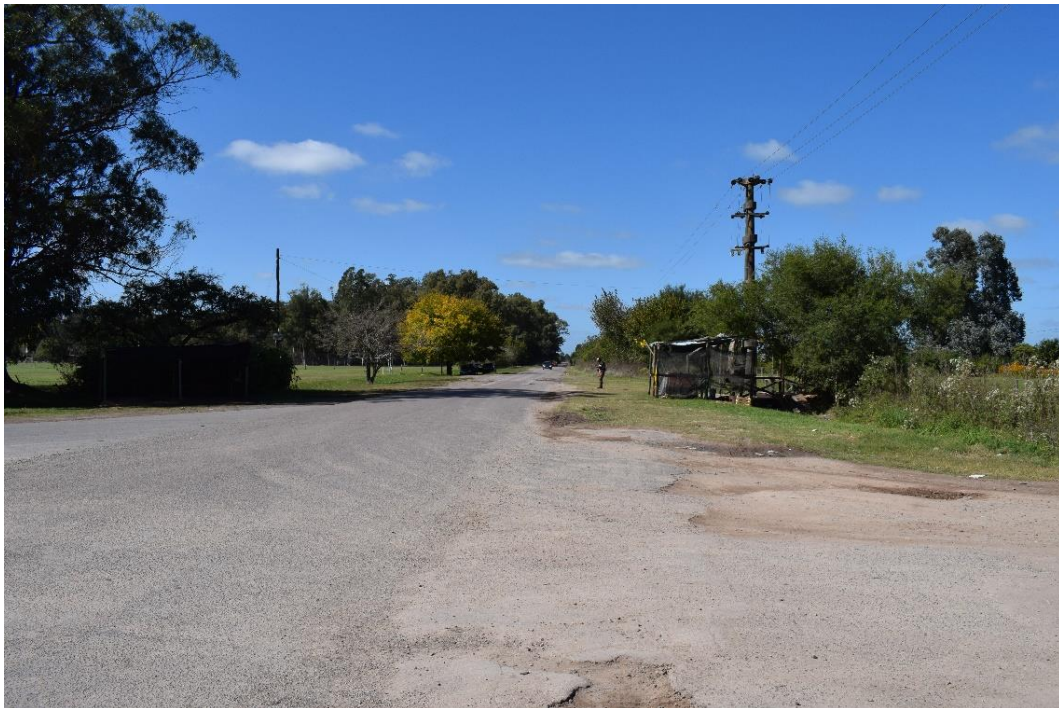
Figura N° 5 – Camino Costa Sur desde Av. 66 hacia calle 78
