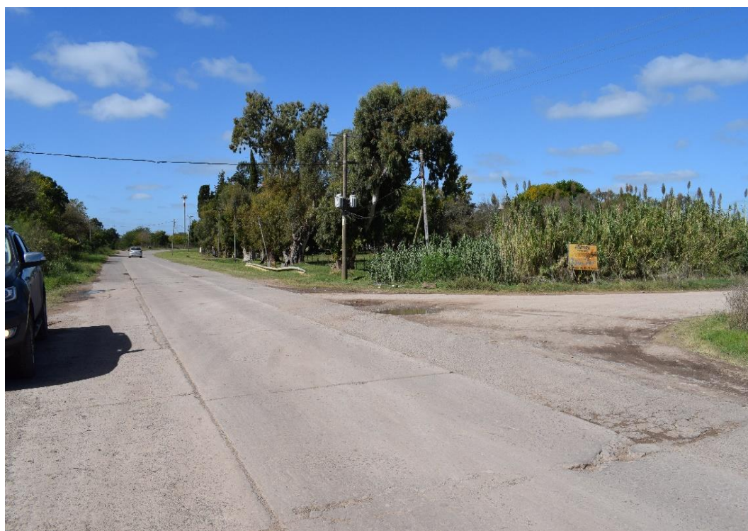
Figura N° 7 – Camino Costa Sur desde calle 78 hacia RP N° 36
