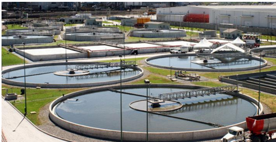
Ilustración 5- 2: Planta de tratamiento de aguas residuales de La Paz -Baja California, México
