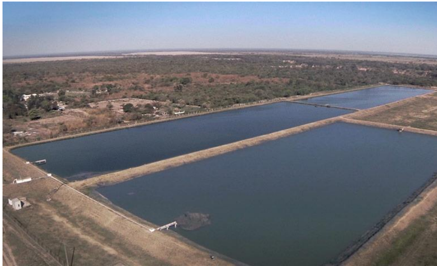
Ilustración 5- 1: Lagunas de oxidación Planta del Norte - ciudad de Salta, Argentina
