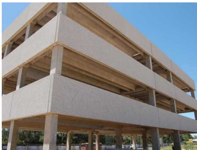
Figura 4- 3: Paneles ubicados horizontalmente
