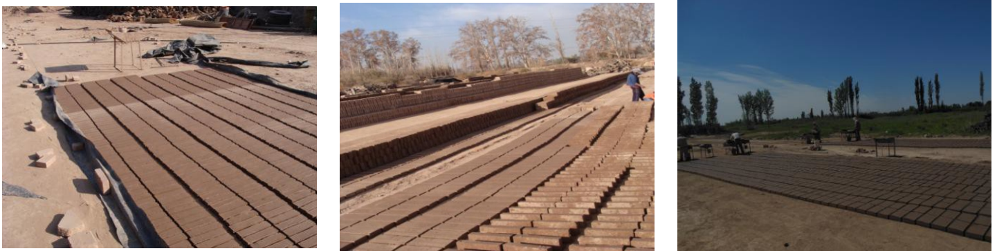
Figura 10. Secado de los adobes Fuente: Elaboración propia
