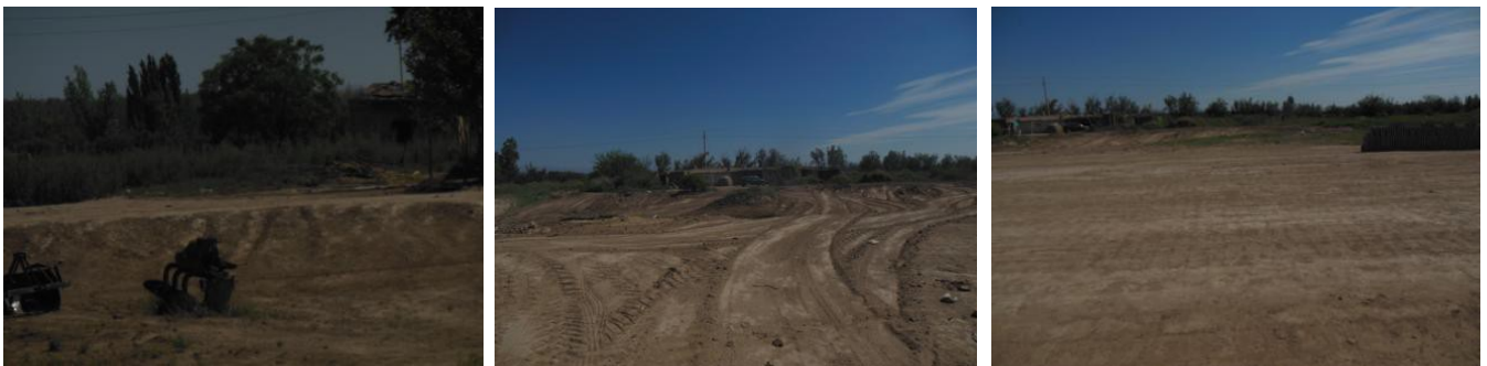
Figura 7. Extracción de la tierra durante la fabricación de ladrillos Fuente: Elaboración propia
