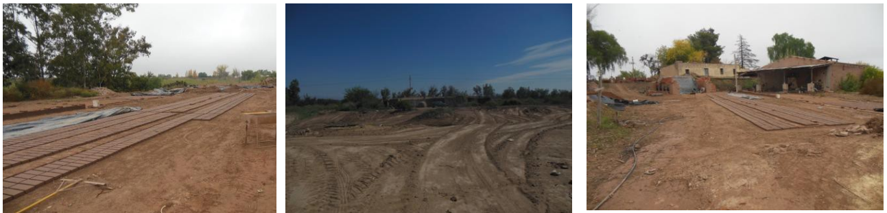
Figura 16. Nivel del terreno en zona de trabajo
