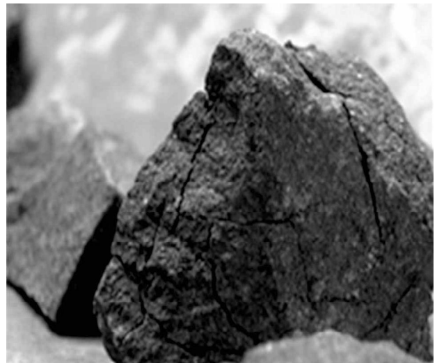
Figura 9. Muestra fisurada a 90 días. Segundo ángulo.
