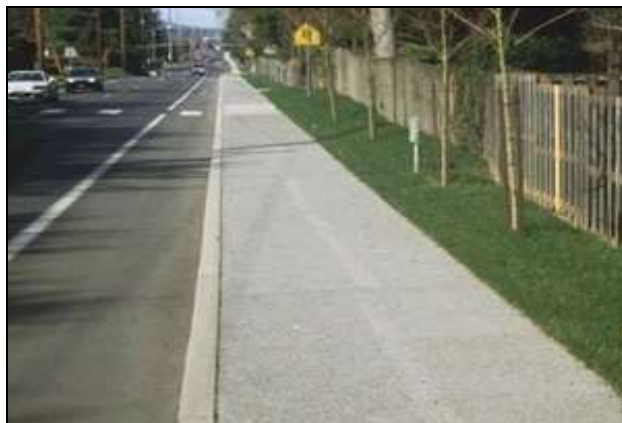
Figura II-10 – Hormigón poroso usado como vereda en Olympia, WA, EE.UU. (Fuente: EPA - NPDES, 2009)
