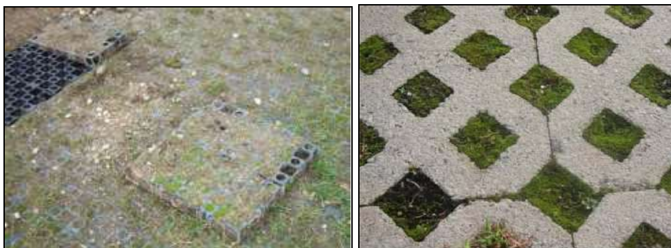
Figura II-2. Césped con refuerzo plástico (Izquierda) y con refuerzo de hormigón (derecha). (Fuente: Rodríguez Hernández, 2008 – García Haba, 2011)
