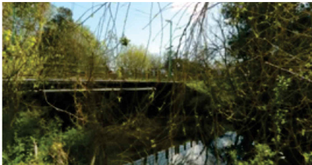
Figura 1. Puente sobre el arroyo Doña Flora.
