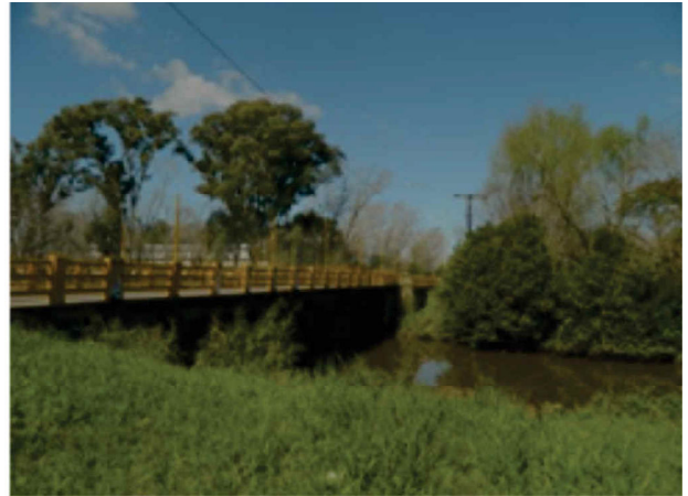
Figura 3. Puente sobre el canal del Arroyo Rodríguez.
