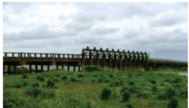
Figura 9. Puente esclusa sobre Canal 1 (Tordillo).
