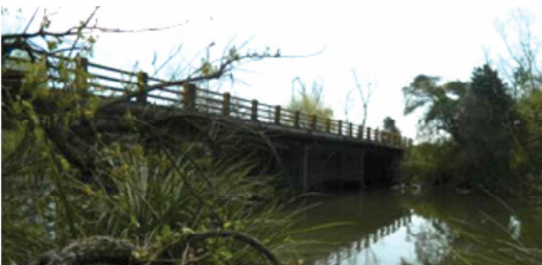
Figura 2. Puente sobre el canal del arroyo El Gato.
