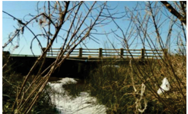
Figura 4. Puente sobre el Arroyo Miguelín.
